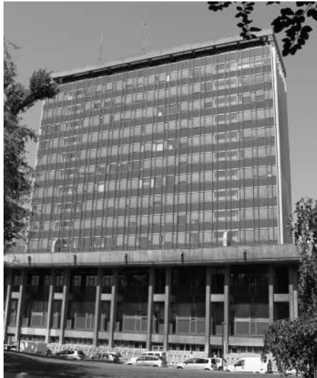
Figure 5.1. Ouvrage – vue globale
