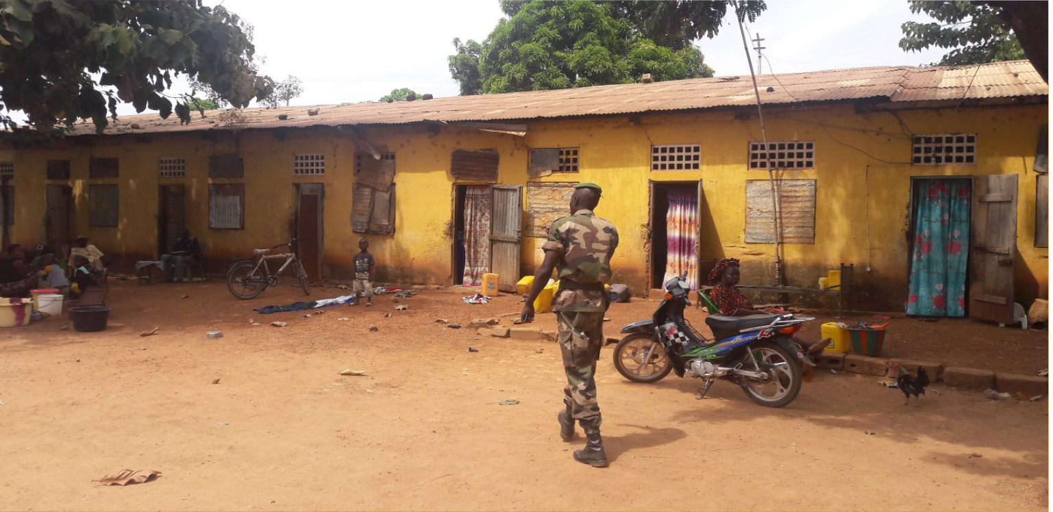
Logements du quartier résidentiel du « voile de la mariée » dans le camp Soundiata Keïta de Kankan, Guinée, novembre 2017. Photo : Anna Dessertine.
