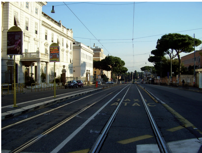
Fig. 1 – Fermate di autobus e installazioni della tramvia sul Viale Regina Elena (foto dell'autore, marzo 2008).
