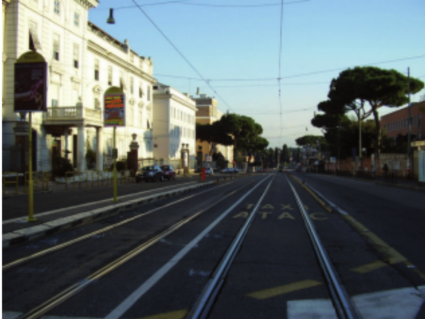
Fig. 1 – Arrêts d'autobus et installations du tramway sur le Viale Regina Elena 59 .
