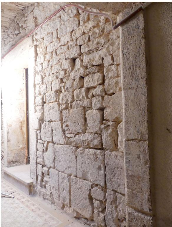
Détail des maçonneries de moyen appareil de taille et en petit moellon du mur MR1007 au deuxième étage de maison, signalant deux surélévations successives, avec percement d'une fenêtre à cheval sur les deux (bouchée). A l'arrière-plan, la porte de communication entre la coursive et la salle 2.7 au deuxième étage.
