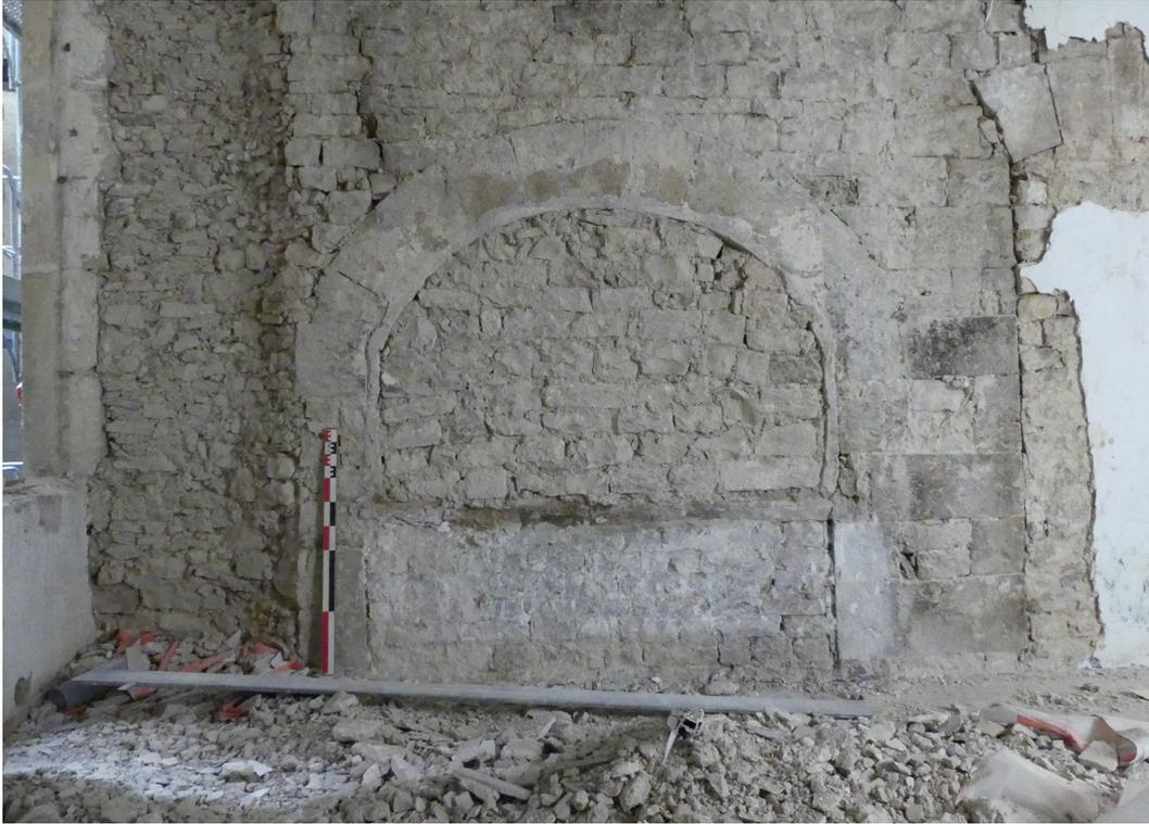
**Fig. 34** Le pignon occidental MR1017 de la maison du 15 place aux Herbes, face externe (aujourd'hui dans un immeuble) et sa porte du premier étage. On note, à gauche, le délardement du mur réalisé pour créer une embrasure à la fenêtre de la phase Cl. M. Rochette/Inrap.
