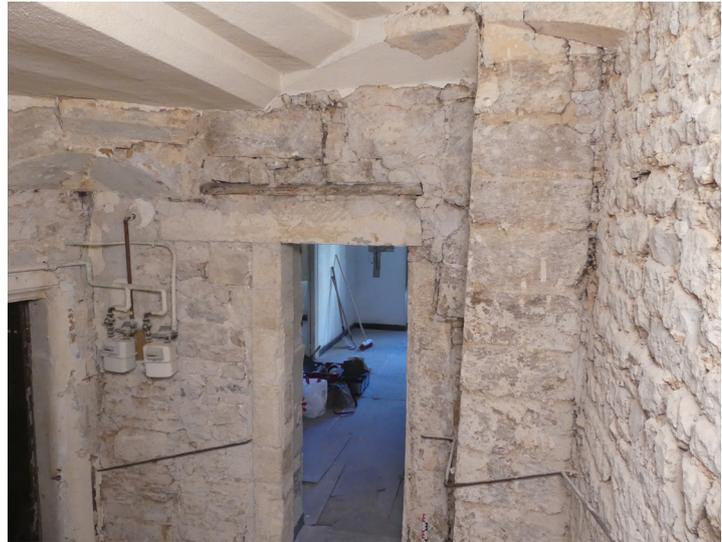
**Fig. 30** Vestiges du premier escalier en vis dans les angles de la cage. Ici le mur de façade méridionale MR1007 du corps de logis principal au premier étage avec sous les marches de l'escalier postérieur ES1034, les consoles de support des degrés du premier escalier. On note à gauche la porte 1049 donnant sur la loggia et à droite la porte 1046/1047 dans son dernier état. Cl. O. Mauftras/Inrap.
