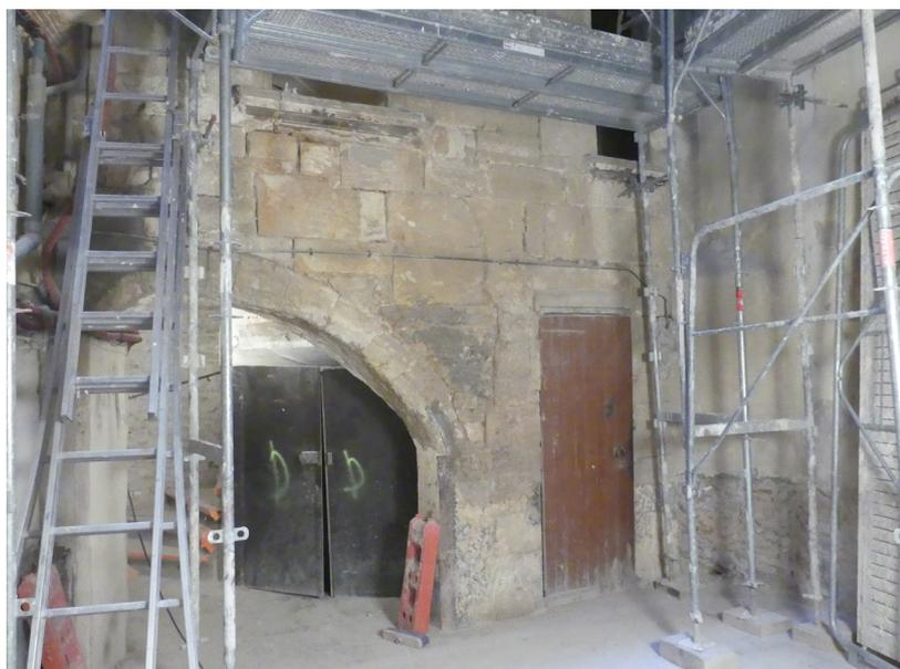
**Fig. 27** La base du mur MR1027 de la cage de l'escalier en vis, vu depuis la cour, avec l'arc rampant d'accès à la première révolution et le portillon vers un passage entre deux immeubles à l'extérieur de la parcelle. Cl. O. MaufRAS/Inrap.
