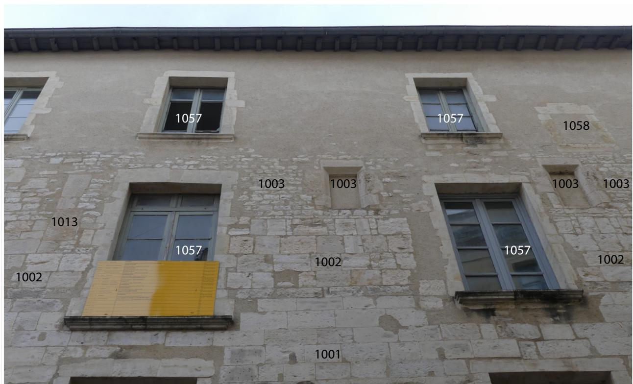
Fig. 23 Les surélévations successives de la façade sur rue MR1001, US 1002 puis US 1003, avec les ouvertures associées à la seconde. Cl. O. Mauftras/Inrap
