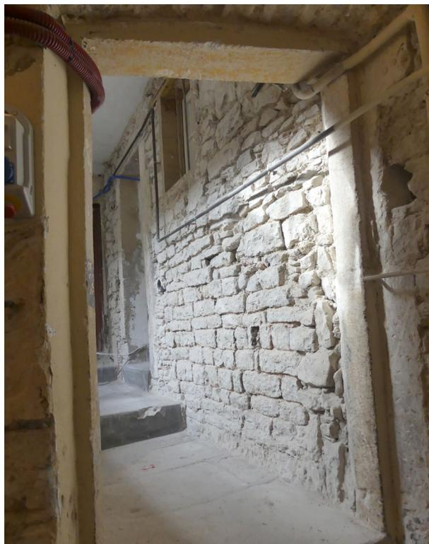
Détail de la maçonnerie du mur MR1007, parement méridional sur coursive, au troisième étage de la maison. Vue d'ensemble et détail de l'appareil régulier de petits moellons.
