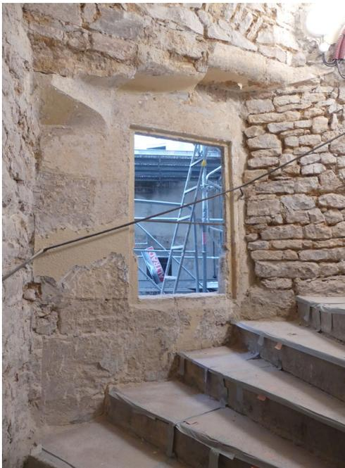
Le mur MR1027 de séparation de la cour et de la cage d'escalier, au troisième étage (juste sous le palier du 3e) avec sa fenêtre plus basse que celles des étages inférieurs. On note l'écoinçon du premier escalier ES1033 dans l'angle sud-ouest de la cage (à gauche) et au-dessus l'extrémité conservée et plus ou moins saillante de trois marches. Ce sont les dernières marches de l'escalier dans son état initial. Elles correspondent au sommet conservé du mur MR1027 dans son premier état.
