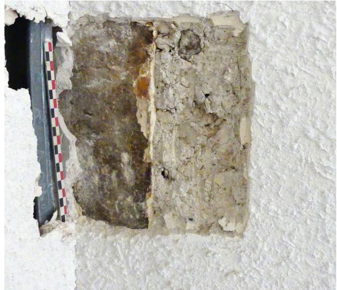
Détail du petit sondage dans l'angle nord-ouest de la pièce 1.4 au premier étage de la maison. À gauche le doublage du pignon occidental de la maison, MR1019, à droite le revers US 1016 de la façade MR1001, avec en gris foncé le pan roman 1001 du mur et, à droite, le bouchage contemporain de la fenêtre 1057.
