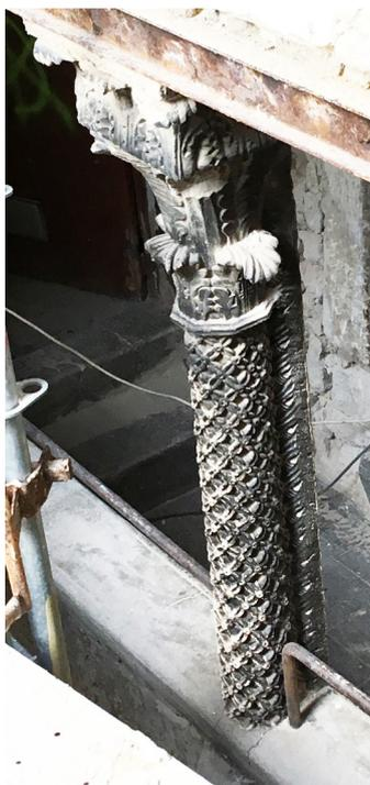
**Fig. 16** La colonnette 1060 (1,52 m de haut comprise la base, ici masquée) en remploi dans la loggia du 3<sup>e</sup> étage de l'immeuble, initialement au centre d'une des quatre baies géminées de la façade. Cl. M. Rochette/Inrap.
