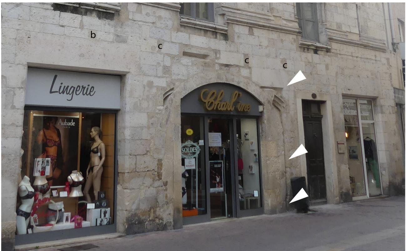
**Fig. 9** Les ouvertures de la façade MR1001 de la maison romane au rez-de-chaussée. Les baies aux extrémités de gauche (est) et de droite (ouest) sont d'origine (phase 1). La porte d'entrée est très récente (phase 6) et la vitrine centrale reprend l'emplacement du porche médiéval dont les flèches blanches pointent les vestiges (piédroit et angle de celui-ci et du linteau). **B** : boulin. **C** : chandelles. Cl. O. Maufrais/Inrap.
