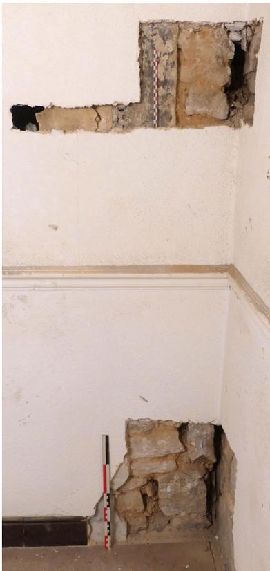
Vue d'ensemble des sondages pratiqués dans l'angle nord-ouest de l'espace 1.7. A gauche le mur de refend MR1014 avec un piédroit mince à proximité de l'angle que l'on ne retrouve pas au sol (placard avec bouchage à gauche). A droite le revers US 1015 de la façade MR1001.
