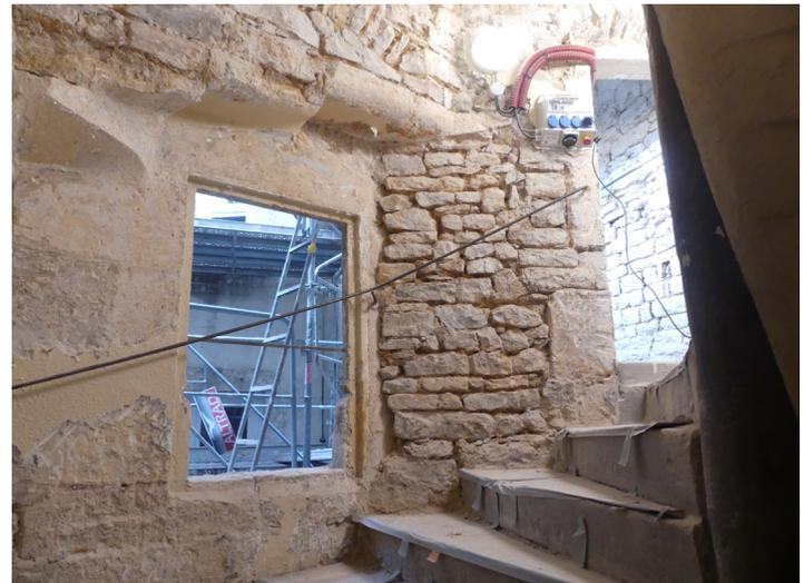
**Fig. 31** Le revers de la fenêtre percée dans le mur MR1027 entre le 2<sup>e</sup> et le 3<sup>e</sup> étage pour éclairer l'escalier en vis et, au-dessus, la console d'angle et les extrémités de marches du premier escalier. On remarque, à droite, le doublage interne du mur en petits moellons et la porte ajoutée au cours de la phase 5. Cl. O. Mauftras/Inrap.
