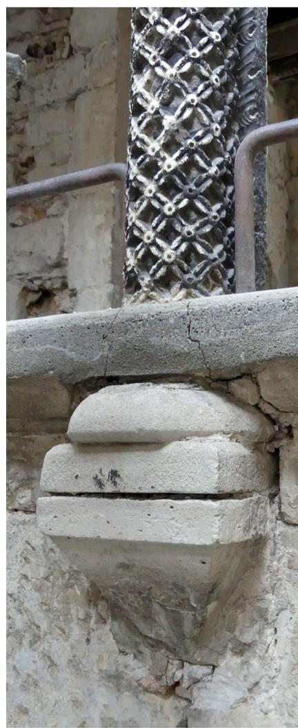
La colonnette 1060 de la coursive du troisième étage. Détail de la base prise dans la main courante cimentée du garde-corps.
