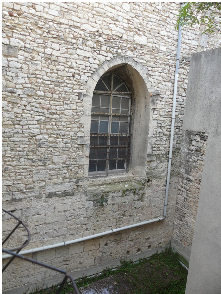
Fig. 4 La base médiévale de l'église Sainte-Eugénie, vue depuis l'extension moderne de la maison romane. On note le moyen appareil de taille en pierre de Roquemailère qui s'apparente à celui de la façade du 1 rue de la Madeleine. Cl. M. Rochette/Inrap.
