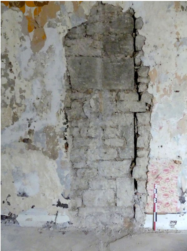
Pièce 3.6 au troisième étage : le mur oriental MR1017, ici sa surélévation US 1021 formant chaînage, contrebutée par une reprise en hauteur du mur MR1018. Détail de la jonction des deux murs.
