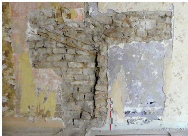
Pièce 2.6 au deuxième étage : sommet du mur MR1017 dans son premier état et pente du toit. Surélévation US 1021 au-dessus et extension vers le sud (la droite) MR1018.
