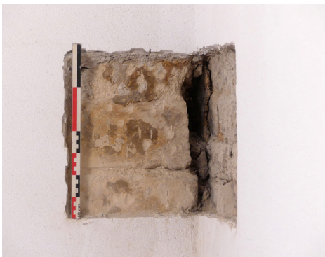
Détail de l'appui du mur MR1009 (à gauche, à l'est) sur la maçonnerie antérieure US 1006 du mur MR1005 (à droite, au nord-ouest). (Pièce 1.8 : espace à l'extrémité nord-est de l'îlot, à l'angle de la rue de la Madeleine et de la Place aux Herbes, au premier étage)
