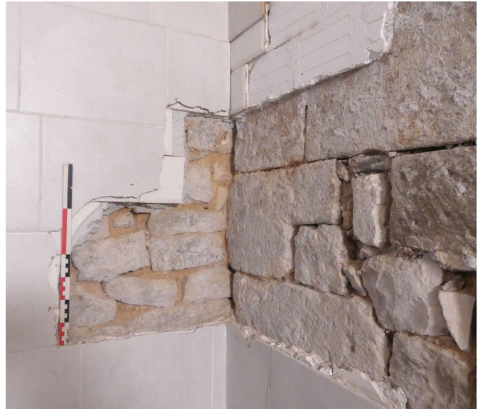
Le sondage dans l'angle sud-est de la pièce 1.7 (espace central du corps de logis sur la rue de la Madeleine au premier étage). A gauche (au nord) la maçonnerie US 1006 à l'extrémité du mur MR1005 et à droite (au sud-ouest) l'extrémité orientale du mur MR1007. Il n'a pas été clairement déterminé si la maçonnerie US 1006 s'appuyait à US 1007 ou l'inverse.
