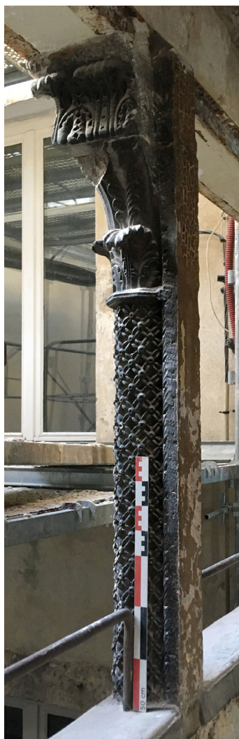
La colonnette 1060 de la coursive du troisième étage. Vue latérale.
