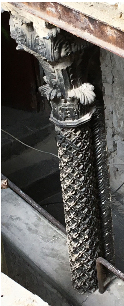
La colonnette 1060 de la coursive du troisième étage. Vue plongeante depuis la fenêtre de l'escalier espace 3.
