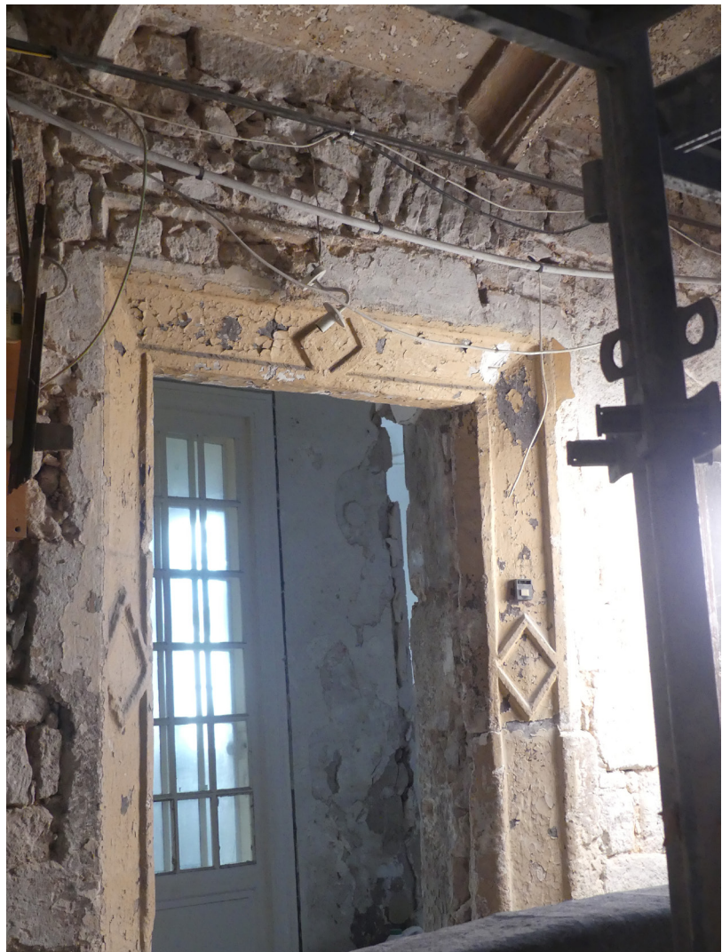
Fig. 39 La porte de circulation entre la loggia et la salle 17, vue depuis l'extérieur. Cl. M. Rochette/Inrap.
