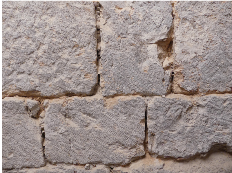
Fig. 21 Détail des traces d'outil sur le parement externe de la façade sur cour MR1007 au premier étage (entre les portes modernes 1035 et 1062) Cl. O. Maufras/Inrap.
