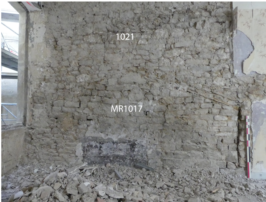
Fig. 35 Le pignon occidental MR1017 de la maison du 15 place aux Herbes, face externe au deuxième étage : sommet du mur, vestiges de la toiture initiale et de sa réfection. Au-dessus, la surélévation 1021 de la phase 4. Cl. M. Rochette/Inrap.
