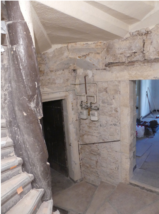
Le palier du premier étage dans l'escalier ES1034 : angle nord-ouest, avec les portes 1049 d'accès à la coursive à gauche et 1046 d'accès à la salle 1.7 à droite.
