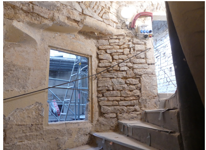
Fig. 31 Le revers de la fenêtre percée dans le mur MR1027 entre le 2 e et le 3 e étage pour éclairer l'escalier en vis et, au-dessus, la console d'angle et les extrémités de marches du premier escalier. On remarque, à droite, le doublage interne du mur en petits moellons et la porte ajoutée au cours de la phase 5. Cl. O. Mauftras/Inrap.
