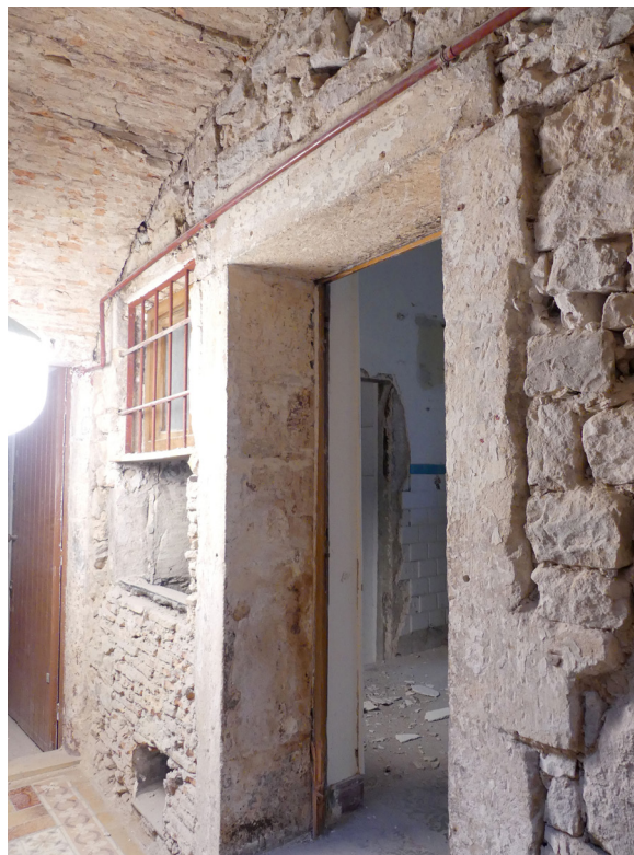
La porte 1053 entre la coursive du deuxième étage et la salle 2.7. Vue générale du sud-est, détails vus du sud.
