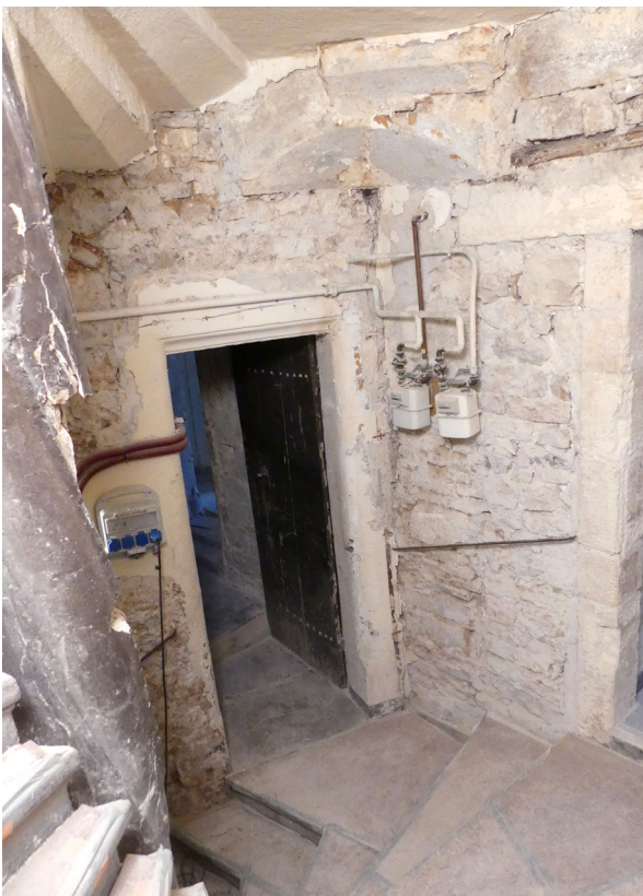
Le palier du premier étage dans l'escalier ES1034 : angle nord-ouest, avec les portes 1049 d'accès à la coursive à gauche et 1046 d'accès à la salle 1.7 à droite.
