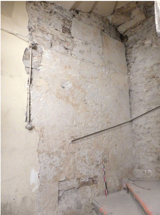
Le mur septentrional MR1007, ici doublé par la maçonnerie US 1031, de la cage d'escalier 3 au rez-de-chaussée (espace 0.3). Vue d'ensemble et de détail.
