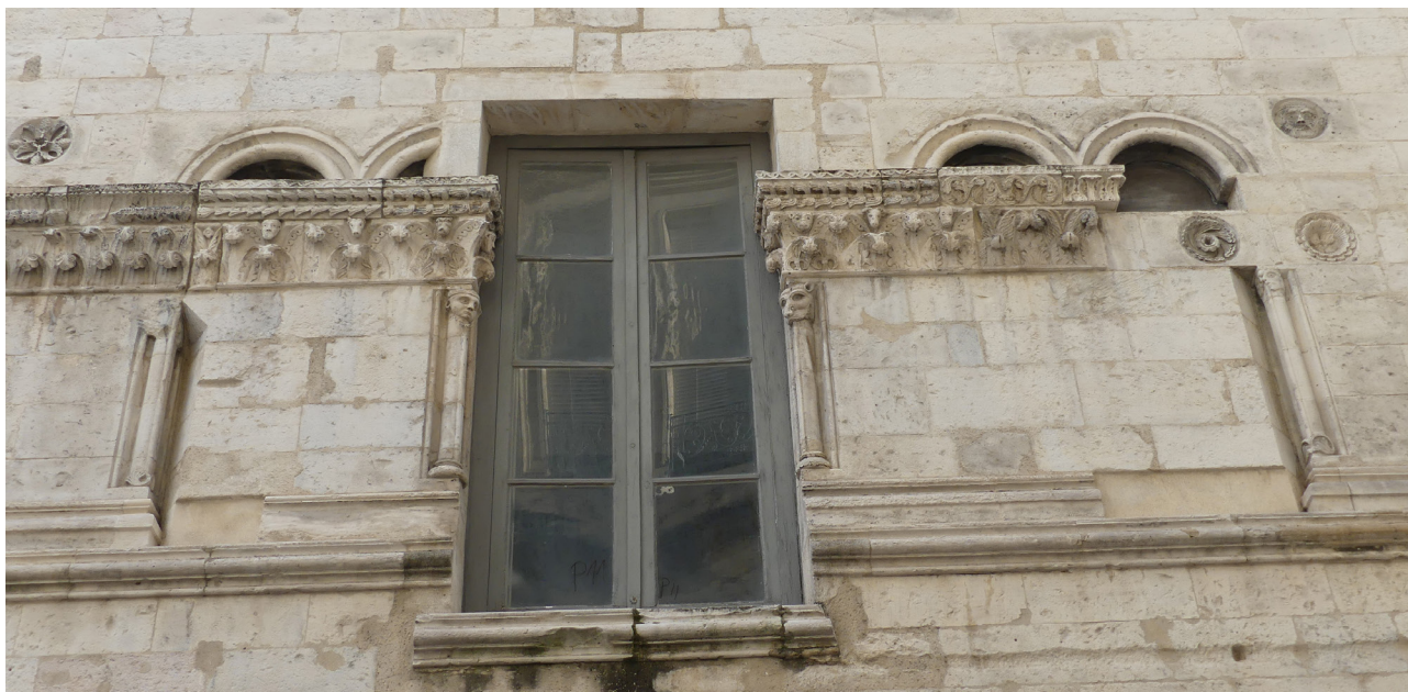
Fig. 15 Détail des deux fenêtres médiévales de l'ouest sur la façade MR1001 au premier étage recoupées par la fenêtre contemporaine 1057 qui s'intercale entre les deux. Les ouvertures du Moyen Âge ont été bouchées lors de la réfection par les pierres moulurées et sculptées démontées par ailleurs. Cl. O. Maufras/Inrap.
