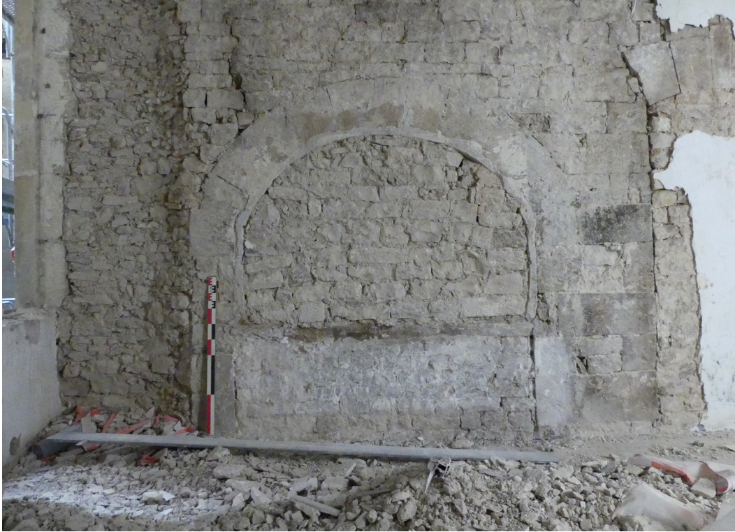
Fig. 34 Le pignon occidental MR1017 de la maison du 15 place aux Herbes, face externe (aujourd'hui dans un immeuble) et sa porte du premier étage. On note, à gauche, le délardement du mur réalisé pour créer une embrasure à la fenêtre de la phase Cl. M. Rochette/Inrap.
