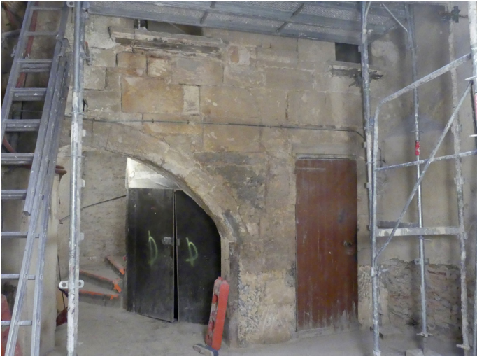
Le mur oriental de la cour, MR1027, au rez-de-chaussée avec à gauche (au nord) son arc rampant d'ouverture vers l'escalier 3 et à droite la porte de desserte d'un espace réduit.
