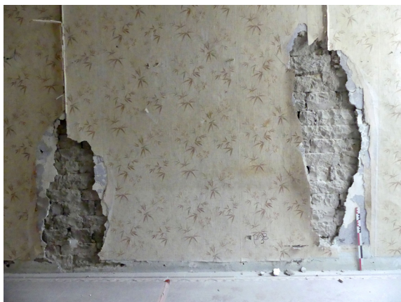
Pièce 2.6 au deuxième étage : le mur méridional MR1018 en petit appareil de moellons équarris à joints fins. Vue d'ensemble des zones observées et vues de détail.
