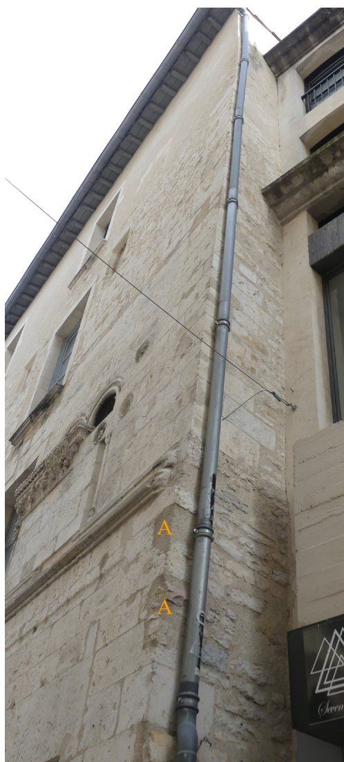
Fig. 6 L'angle occidental de la maison romane avec à gauche la façade en moyen appareil de taille donnant sur la rue de la Madeleine et à droite le pignon en retour MR1019 en appareil de petits moellons. En deux points de l'angle (A) on remarque le bouchage d'une extrémité d'arc arraché. Cl. O. Maufra/Inrap.
