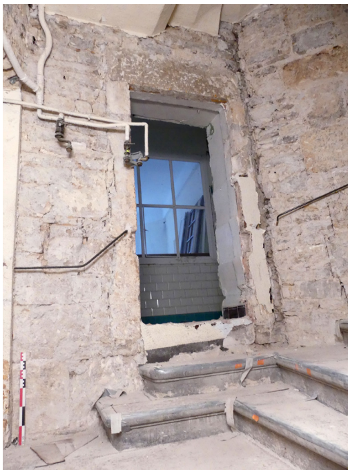
Le mur MR1007 et la porte de séparation entre la pièce 2.7 et la cage d'escalier au deuxième étage. On note à droite le pan coupé correspondant à la structure bâtie SB1059, probablement de confortement.
