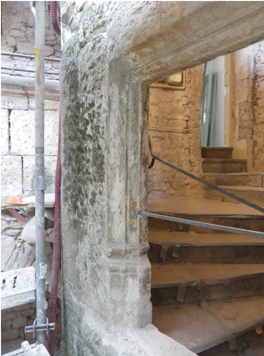
Fig. 29 Fenêtre percée dans le mur MR1027 au 3 e étage pour éclairer l'escalier en vis ES1033. Cl. O. Mauftras/Inrap.
