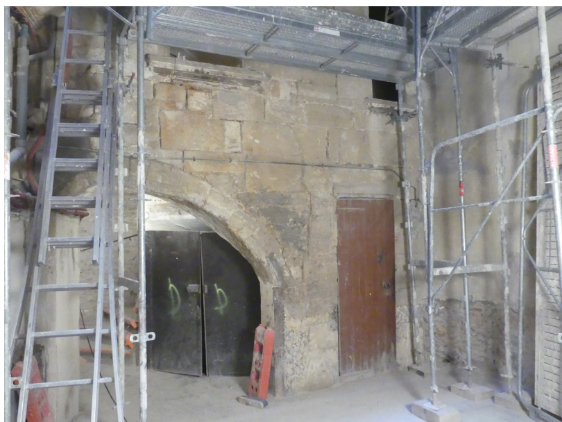
Fig. 27 La base du mur MR1027 de la cage de l'escalier en vis, vu depuis la cour, avec l'arc rampant d'accès à la première révolution et le portillon vers un passage entre deux immeubles à l'extérieur de la parcelle. Cl. O. Maufra/Inrap.
