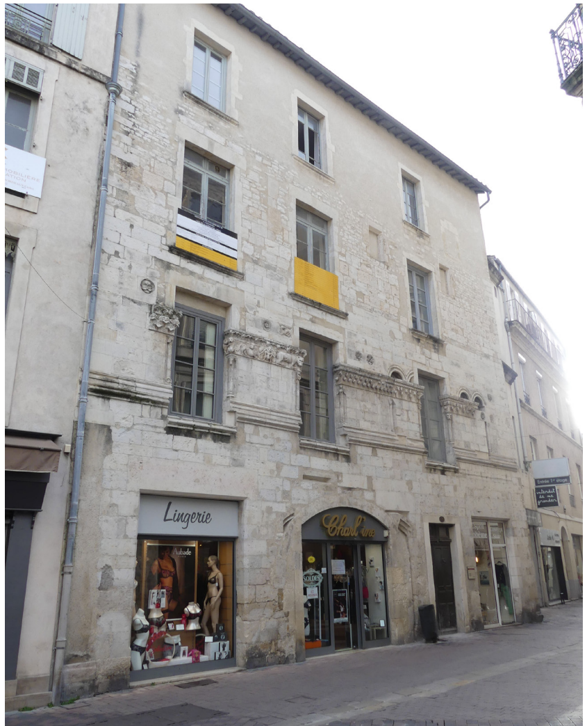
Vue d'ensemble de la façade septentrionale MR1001 de la maison romane.
