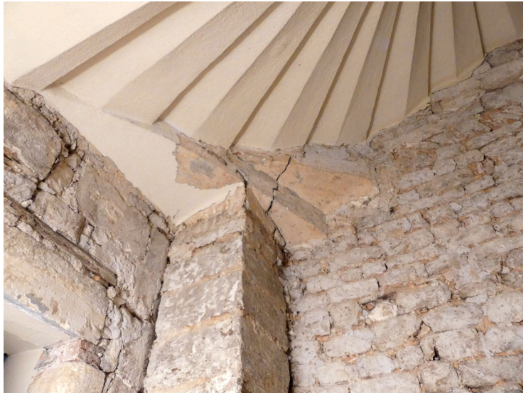
Ecoinçon de soutènement des marches de l'escalier ES1033 au premier étage, dans l'angle nord-est de la cage d'escalier. L'écoinçon a été repris en sous-cœuvre par le massif maçonné 1045, probablement au moment du remplacement de l'escalier initial ES1033 par le suivant, aujourd'hui en place, ES1034.
