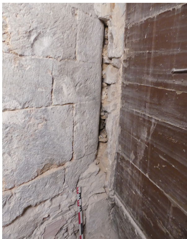
Fig. 12 Détail de l'angle adouci du montant occidental de la porte 1062, côté externe, vu du sud. À droite, le battant de la porte plus tardive 1049. Cl. M. Rochette/Inrap.
