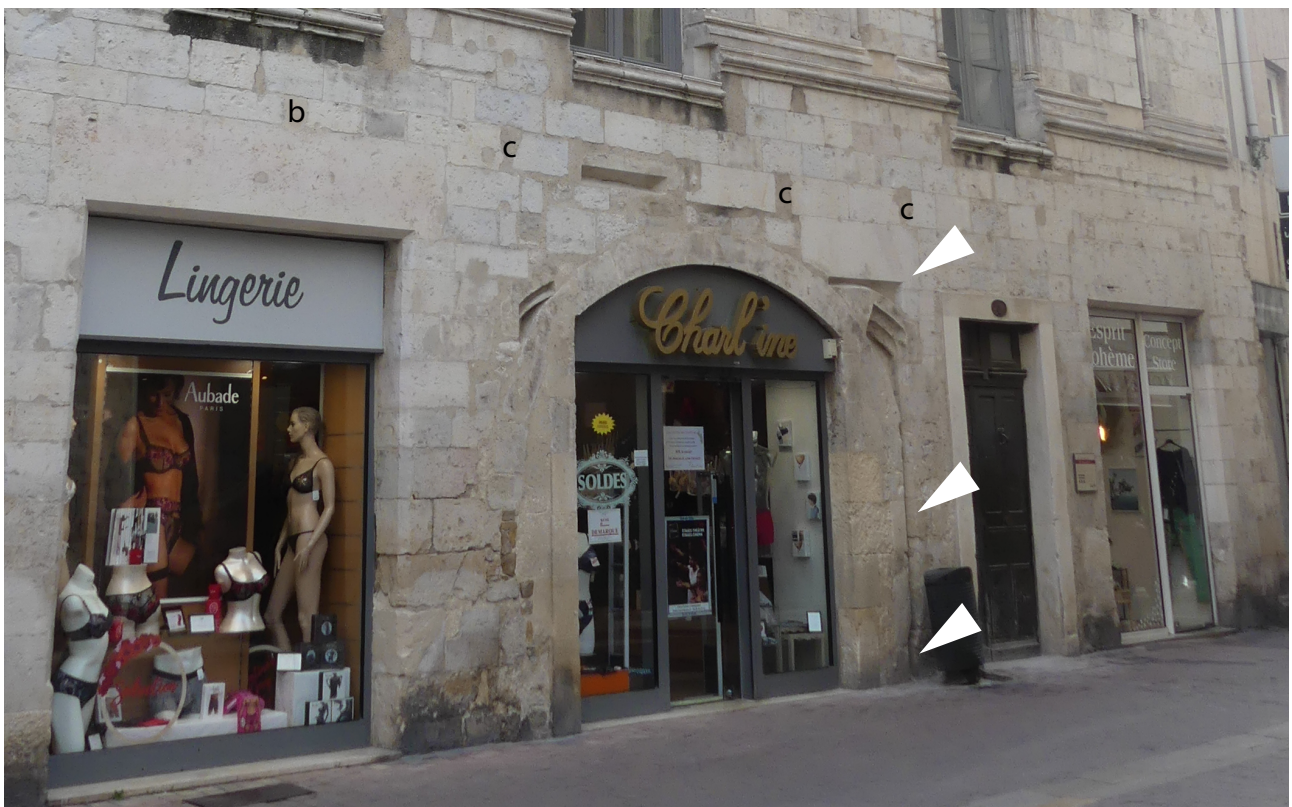
Fig. 9 Les ouvertures de la façade MR1001 de la maison romane au rez-de-chaussée. Les baies aux extrémités de gauche (est) et de droite (ouest) sont d'origine (phase 1). La porte d'entrée est très récente (phase 6) et la vitrine centrale reprend l'emplacement du porche médiéval dont les flèches blanches pointent les vestiges (piédroit et angle de celui-ci et du linteau). B : boulin. C : chandelles. Cl. O. Maufrais/Inrap.
