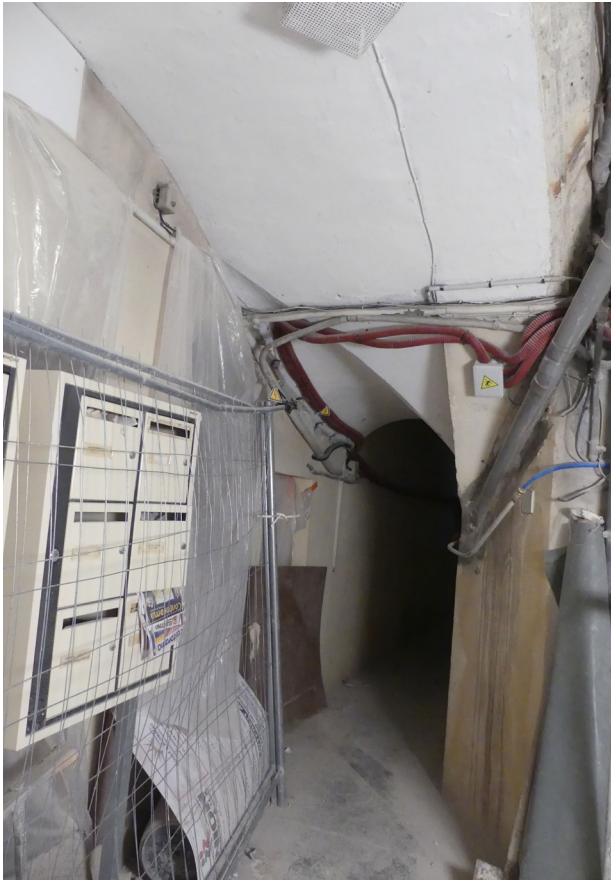
La voûte VT1024 dans l'angle sud-ouest de la cour. Vue de l'angle de la cour vers le couloir d'entrée 01.
