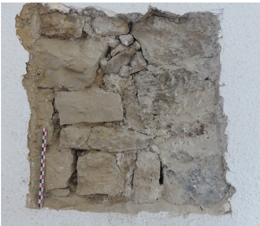
Vue d'ensemble de la pièce 3.7 au troisième étage de la maison, corps sur rue de la Madeleine, et détail de la maçonnerie aperçue dans le cadre d'un petit sondage.
