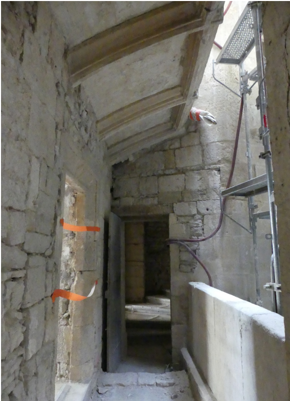
Fig. 37 La loggia au premier étage, vue du sud-ouest. Cl. M. Rochette/Inrap.
