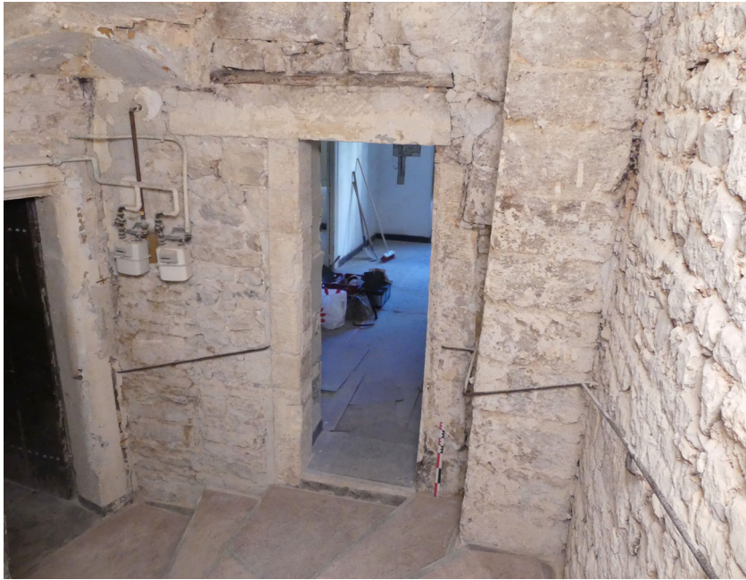
Le mur MR1007 dans sa partie orientale au premier étage de la maison, entre le volume 1.7 et la cage d'escalier 1.3. La porte, 1046, est celle qui communique entre les deux espaces.
