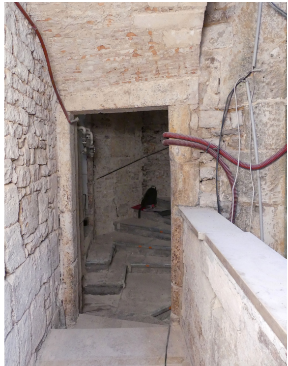
La partie orientale de la coursive au deuxième étage avec le mur MR1007 (pan 1039) à gauche (au nord) et le garde-corps 1041 à droite (au sud). Au fond la porte 1051. Vue d'ensemble et détail de l'appui du piédroit de la porte contre le mur.
