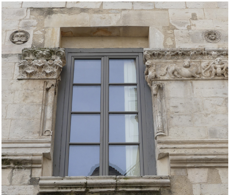
Fig. 14 Détail la fenêtre médiévale de l'est sur la façade MR1001 au premier étage, agrandie par la fenêtre contemporaine 1057. Cl. O. Maufra/Inrap.
