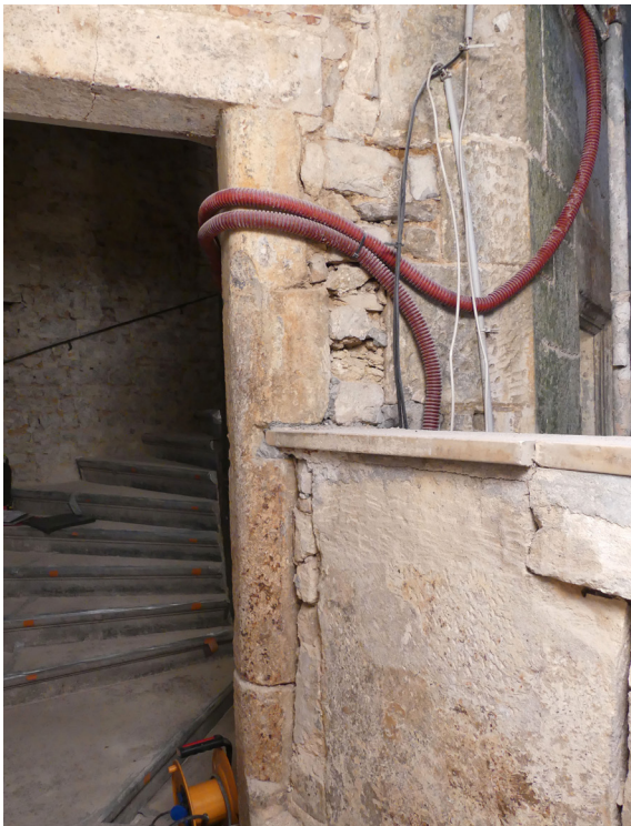
Détail de la jonction entre le garde-corps 1041 de la coursive au deuxième étage et le mur MR1027 entre la cour et l'escalier. On note que la porte 1051 entre la coursive et l'escalier est installée dans une brèche pratiquée à dessein dans le mur MR1027 caractérisé par des bugets et que le parapet s'appuie sur le montant de la porte et la maçonnerie de bouchage de son ancrage.
