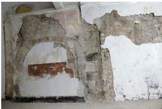
Mur occidental de la pièce 1.6 avec le mur MR1017 et sa baie condamnée au nord (à gauche) et l'extension MR1018 à droite avec sa porte bouchée 1061 au sud (au centre).
