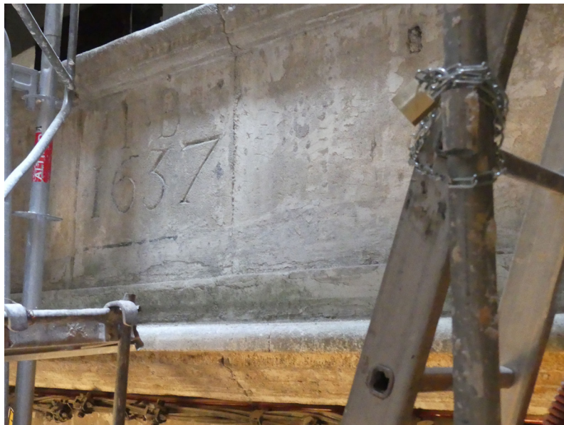
La garde-corps de la coursive au nord de la cour et au premier étage. Vue depuis la cour.
