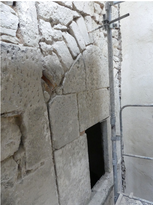
Détail de l'arc de décharge 1043 bâti au-dessus de la fenêtre du troisième étage du cagibi 3.9. au moment de l'exhaussement du mur et de la réfection de la toiture.
