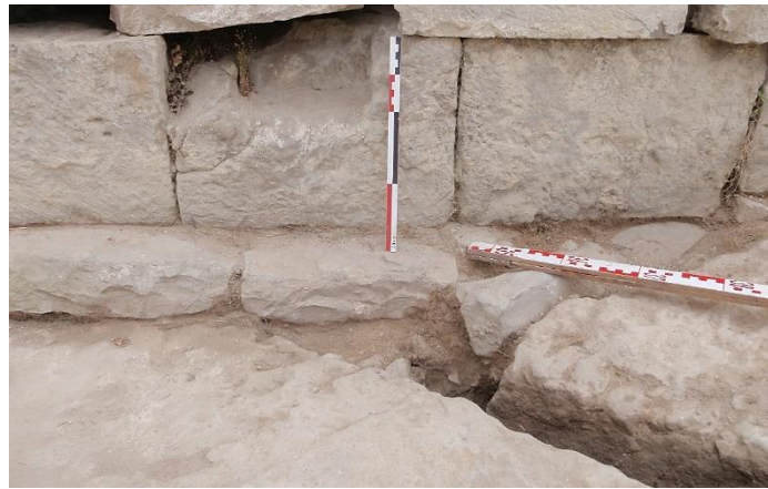
Fig. M66, parement interne, fondation sur le lapiaz et mortaise. Crédit Florence Guillot
