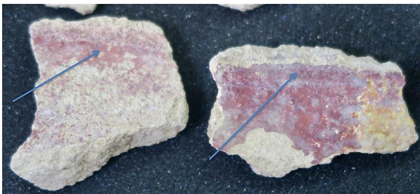
Rupture sur des enduits indiquant un changement de planéité de la surface
