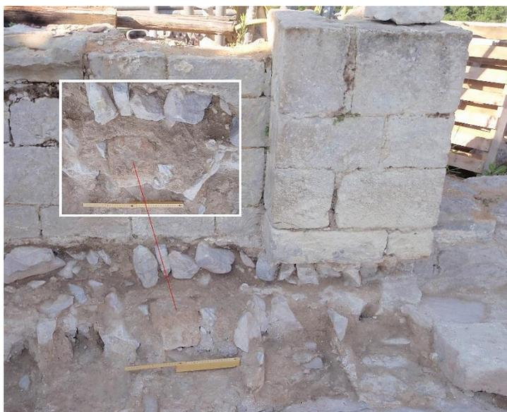
Fig. Fragment de tuf couvert d'enduit peint dans la semelle de fondation du M61. La mire mesure 20 cm.
