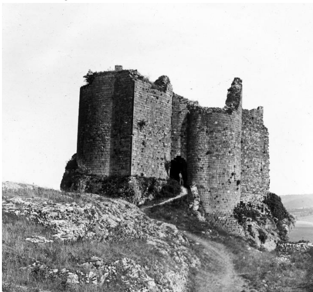
Fig. Ruines du château de Penne (châtelet). Photo d'Eugène Trutat. © Inventaire général Région Occitanie
