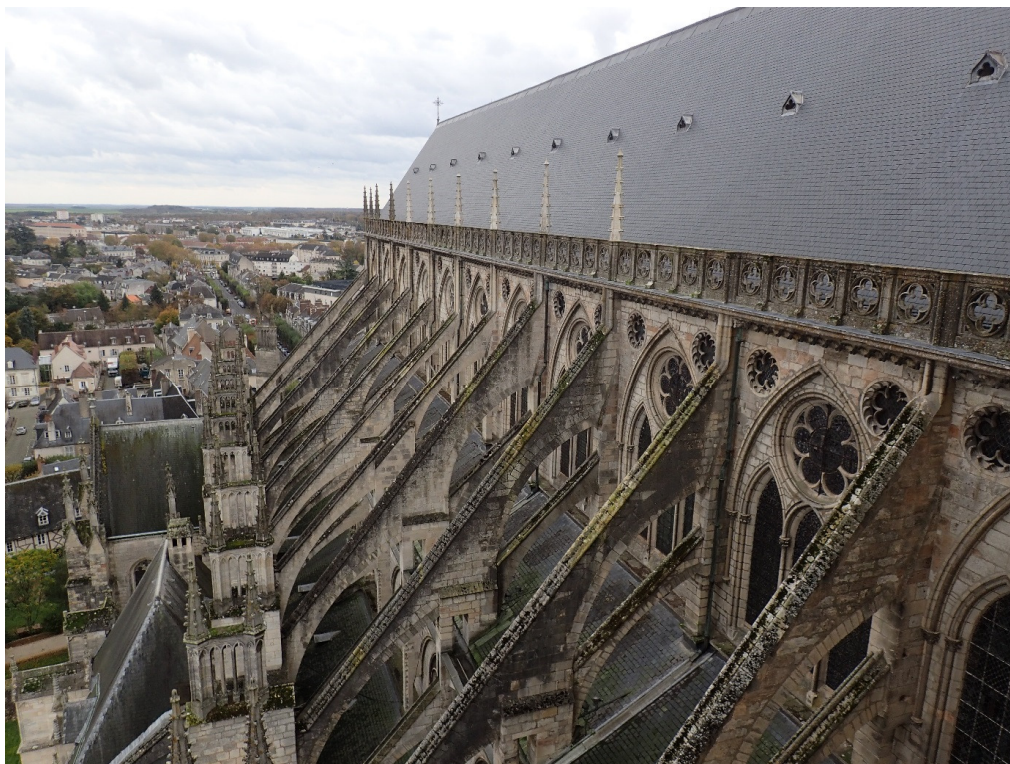
Fig. 7 : Arcs-boutants de la cathédrale de Bourges (Cl. F.E.).
