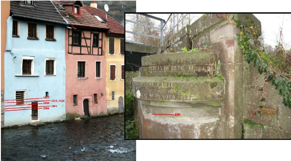
Figure 3. Repères de crues le long de la Thur, à Thann.
