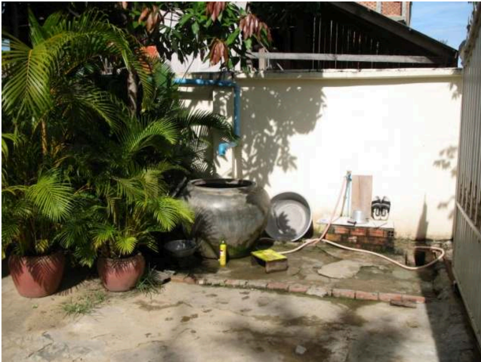
Photo 3 : Cuve en ciment de stockage d'eau (Phnom Penh, Cambodge)
