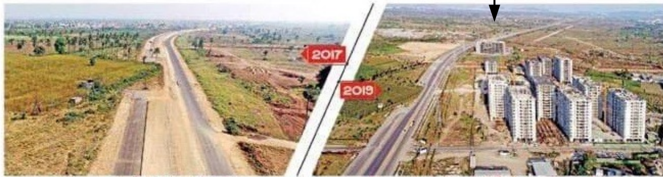
2017 డిసెంబరు: సీడ్ యాక్సెస్ రోడ్డు నిర్మాణంతో మొదలైన పనులు.
