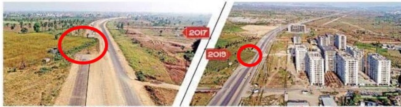
2017 డిసెంబరు: సీడ్ యాక్సిస్ రోడ్డు నిర్మాణంతో మొదలైన పనులు.
