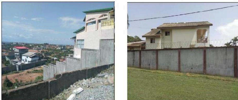
Figure 2. Constructions de haut standing au quartier Balmer.
