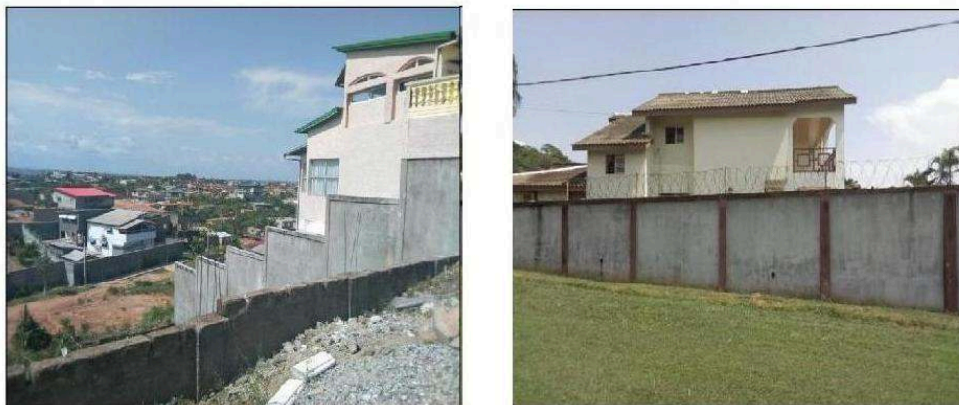
Figure 2. Constructions de haut standing au quartier Balmer.
