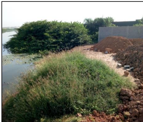
Photo III : Constructions sur un site à risque (quartier Sonouko)
