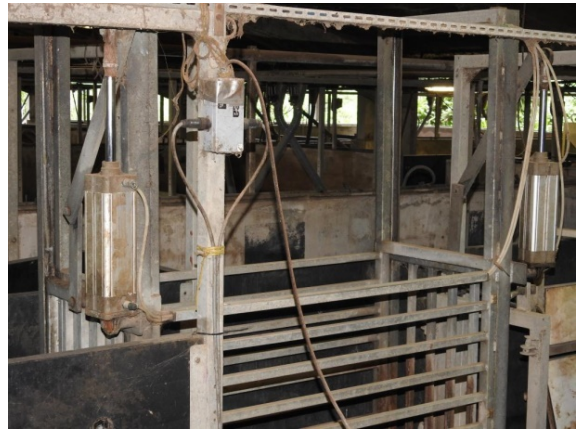
Photo 5. Cage de pesée fermée (portes abaissées)
