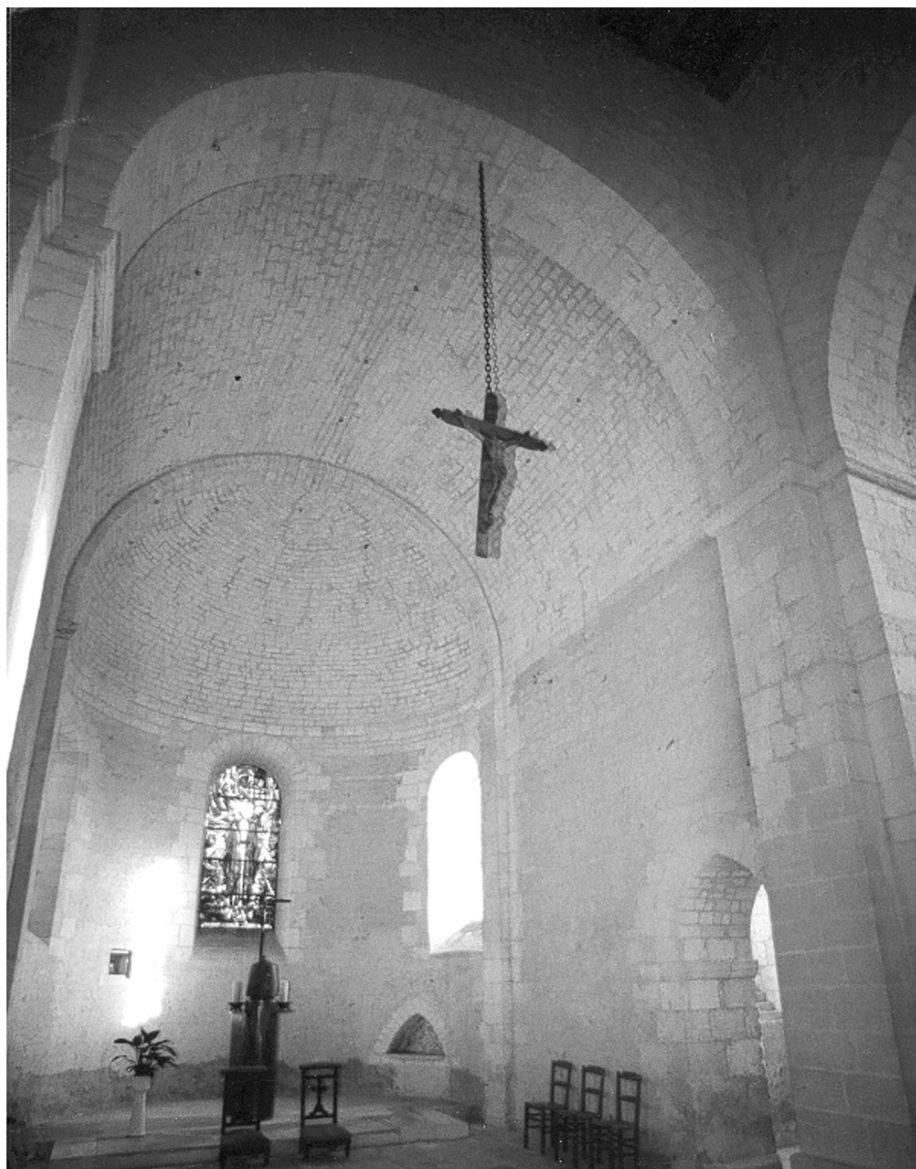
Fig. 3 - Vue intérieure du chœur.
