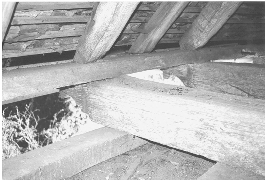
Fig. 17 - Vue intérieure des sculptures des abouts d'entrants.
