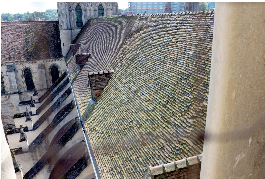
Fig. 6 Nef, versant nord : au premier plan, forte concentration en tuiles médiévales (cl. S. Aumard).
