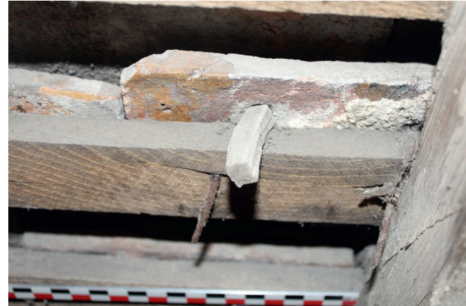
Fig. 10 Nef, versant nord : tuile médiévale sans crochet avec cheville en place (cl. S. Aumard).
