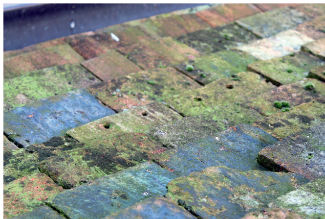
Fig. 7 Nef, versant nord : tuiles médiévales sans crochet à deux perforations et pureaux glaçurés (cl. S. Aumard).
