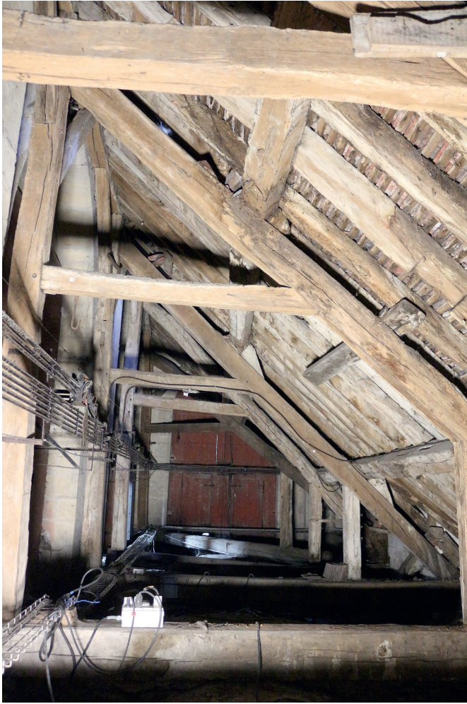
Fig. 3 Charpente du déambulatoire, côté nord (cl. F. Épaud).
