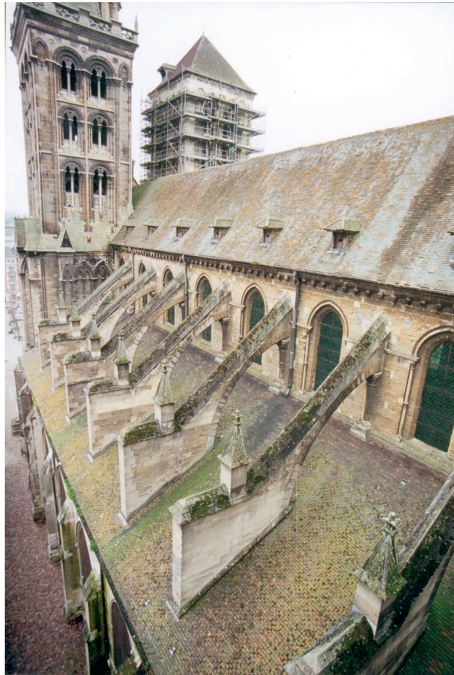
Fig. 1 La cathédrale Saint-Pierre de Lisieux, vue des toitures de la nef (cl. F. Épaud).
