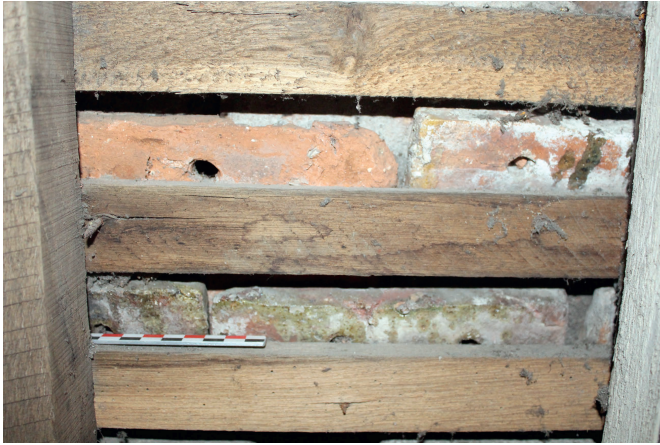
Fig. 9 Transept nord, versant ouest : tuiles médiévales sans crochet à une ou deux perforations; coulures de glaçure de couleur verte (cl. S. Aumard).
