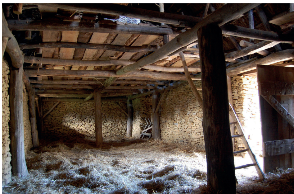
Pl. XIII. Poteaux axiaux de soutien à un plafond constitué d'entrails d'une charpente à chevrons-formant-fermes. Maison expérimentale du x e siècle, archéosite d'Ornavik (14) (Cl. F.E)
