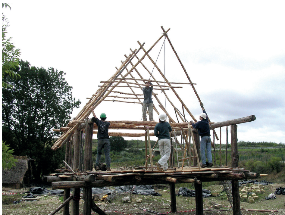
Pl. XI.1. Mise en place d'une faîtière sur une construction expérimentale à poteaux faîtiers (Cl. F.E.)
