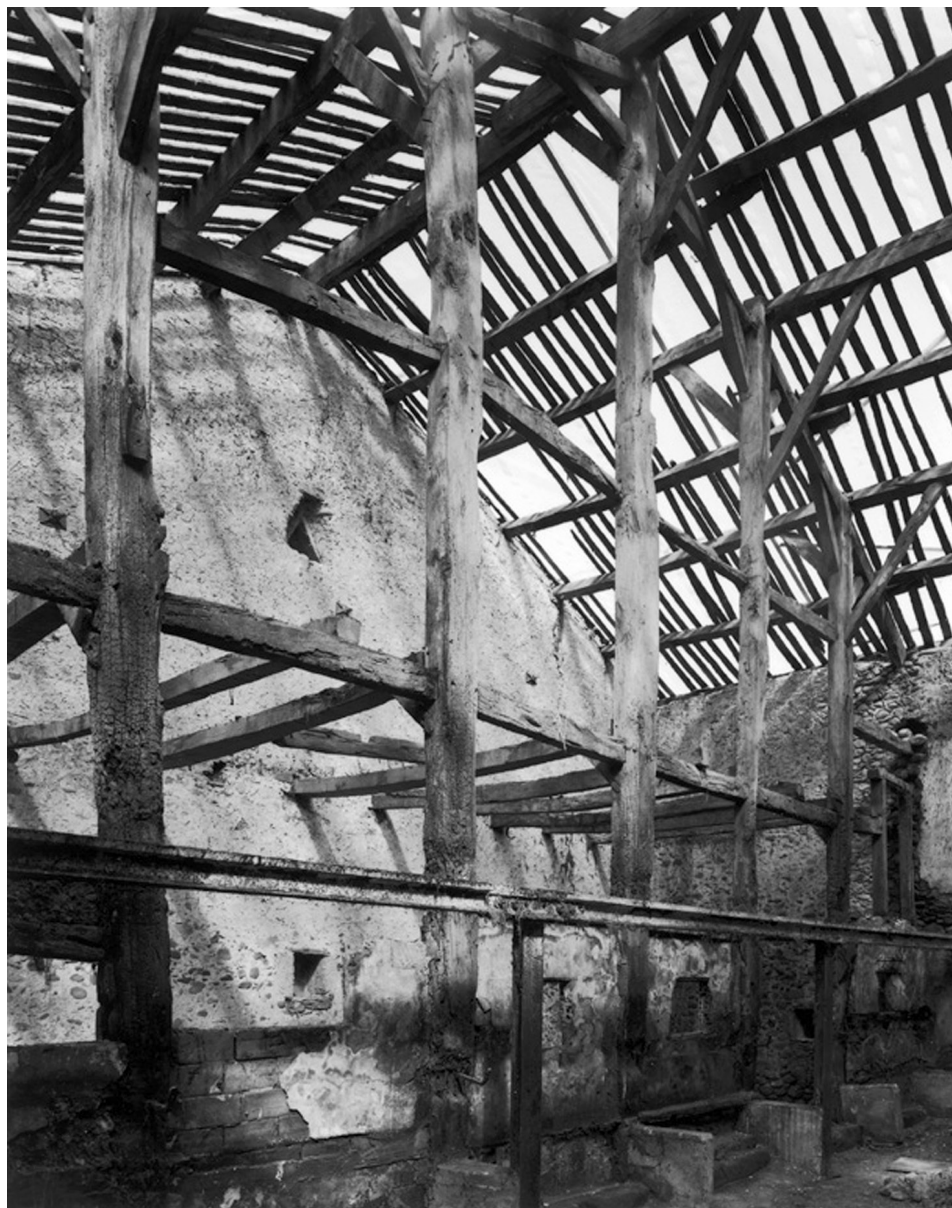
Fig. 5. Grange genevoise à poteau faitier de 1734, à faible pente et anciennement couverte de tuiles creuses (Roland, 2008, fig. 4)
