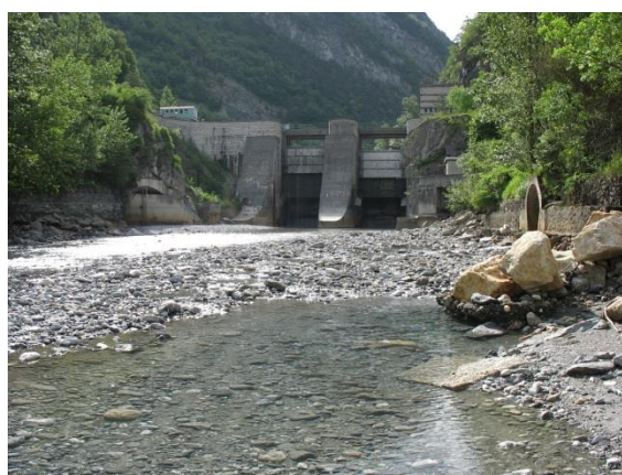
Figure 3 : le site du barrage d'Aigueblanche (rivière Isère) où des chasses sont réalisées environ chaque année. a) vue aérienne de la retenue (Google Earth), b et c) vue de la retenue quasi pleine et vue pendant une chasse (prise vers l'aval depuis le pont). Notez la disparition du banc sablo-graveleux visible en rive droite sur la photo b). d) vue depuis l'aval immédiat des vannes du barrage après la chasse (photos b, c et d © EDF).
