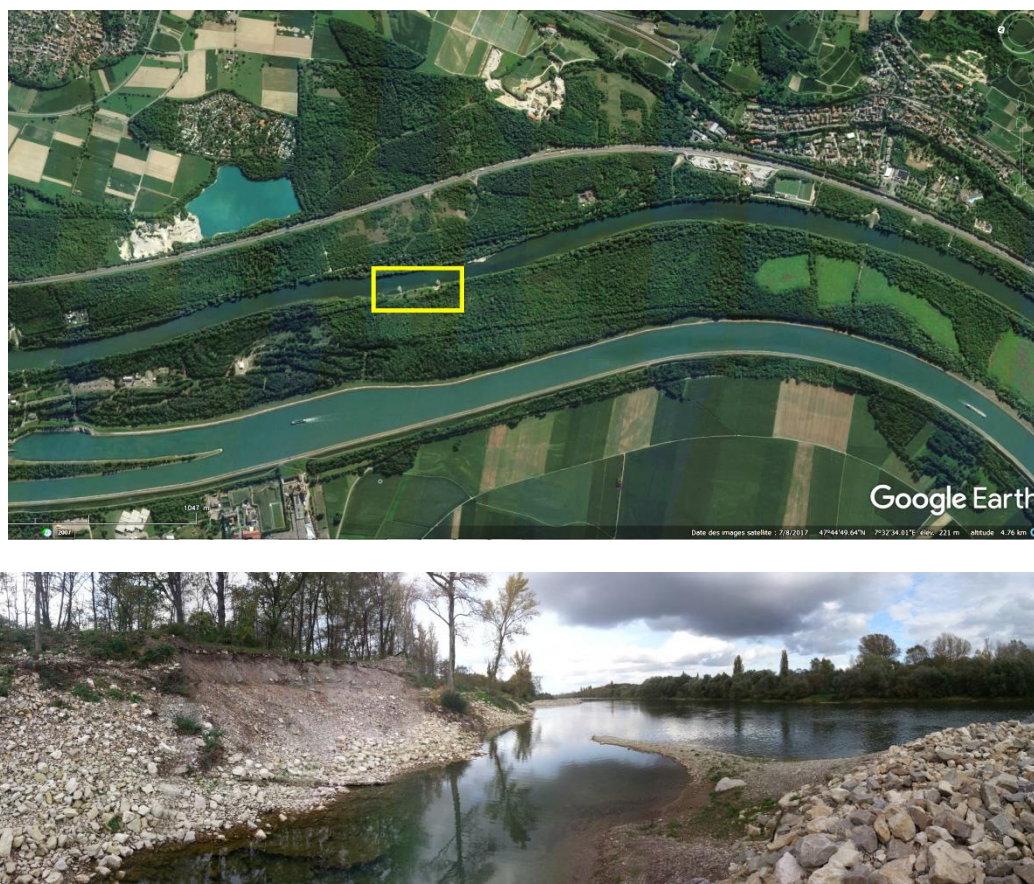
Figure 5 : site du Vieux Rhin en aval du barrage de Kembs. a), dans le rectangle jaune, la zone qui a été désenrochée pour permettre l'érosion latérale (Google Earth). b) vue vers l'aval de cette zone après une crue en 2013 (© EDF).
