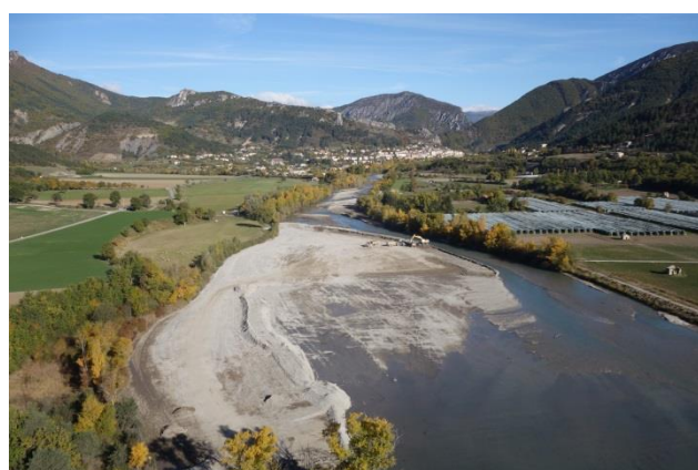
Figure 4 : le site du barrage de Saint Sauveur (rivière Buech) où des chasses sont réalisées régulièrement, mais qui ne suffisent pas à faire transiter la totalité des alluvions grossières qui se déposent en queue de retenue. a) vue aérienne (Google Earth), b) vue vers l'amont de la zone de curage en partie amont de la retenue (sur le delta alluvial), c) vue vers l'amont des deux cordons de réinjection (44000 m 3 au total en 2016) , au fond le barrage et la retenue. (b et c © EDF).
