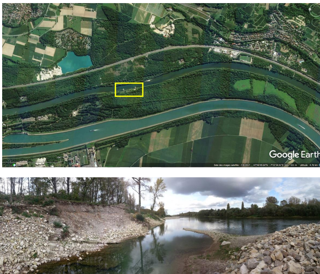
Figure 5 : site du Vieux Rhin en aval du barrage de Kembs. a), dans le rectangle jaune, la zone qui a été désenrochée pour permettre l'érosion latérale (Google Earth). b) vue vers l'aval de cette zone après une crue en 2013 (© EDF).
