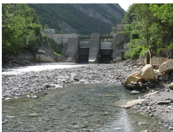
Figure 3 : le site du barrage d'Aigueblanche (rivière Isère) où des chasses sont réalisées environ chaque année. a) vue aérienne de la retenue (Google Earth), b et c) vue de la retenue quasi pleine et vue pendant une chasse (prise vers l'aval depuis le pont). Notez la disparition du banc sablo-graveleux visible en rive droite sur la photo b). d) vue depuis l'aval immédiat des vannes du barrage après la chasse (photos b, c et d © EDF).
