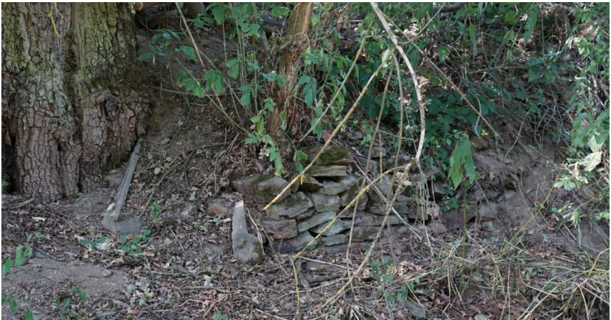
Abb. 9 Mendig, „Im Terl“. Weinbergsterrassenmauer bei Punkt 1 auf Abb. 8. (24.7.2019).
