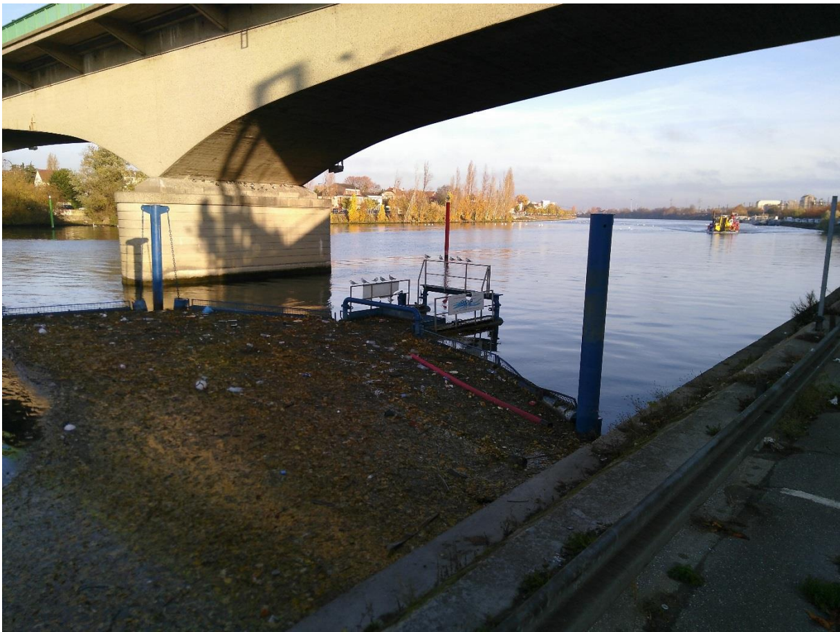
Photo 1 : Barrage flottant de Villeneuve-Saint-Georges en septembre 2018
