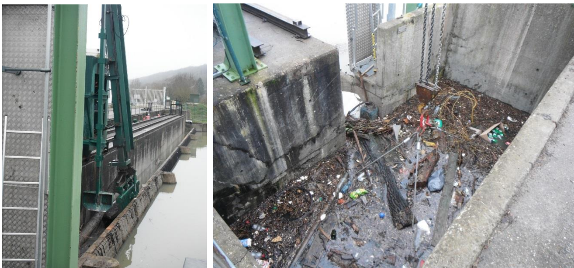
Photo 4 : Dégrilleur automatique et benne à déchets de la centrale hydroélectrique de Port-Mort. La benne est inondée car les photos ont été prises durant la crue de 2018.
