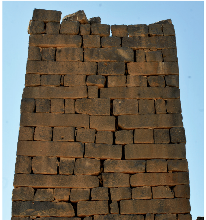
Fig. 32. Fronte settentrionale della torre-minareto del monastero di san Giorgio a Samā, particolare della muratura
