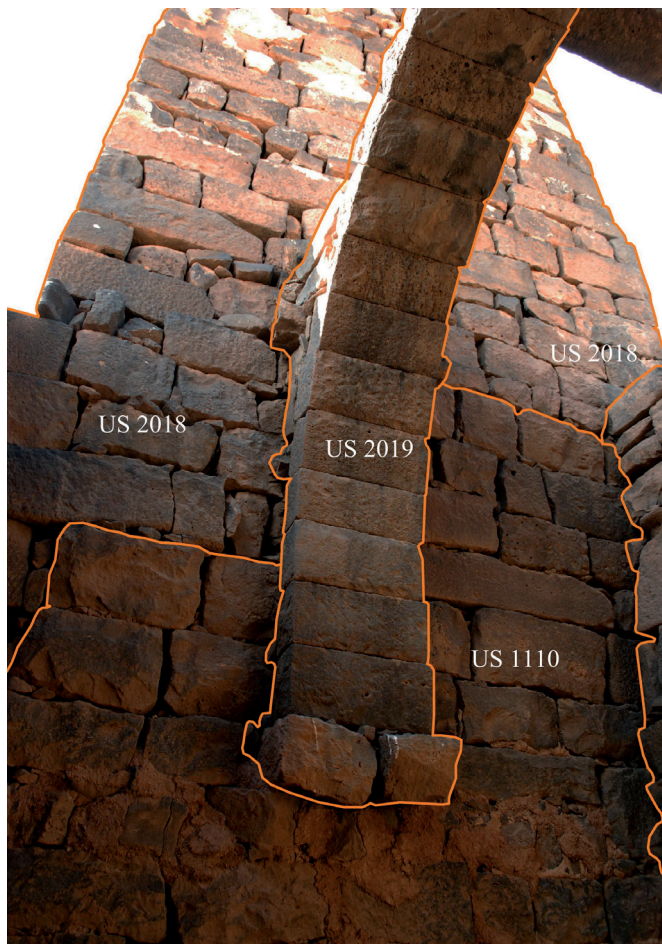
Fig. 29. Vista dall'ambiente 5 del muro settentrionale della prothesis (US 1110) su cui si imposta la parete nord del minareto (US 2018)
