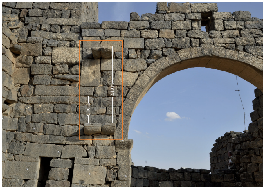
Fig. 34. Particolare del sistema di mensole aggettanti dal muro presbiteriale della chiesa dei santi Sergio e Bacco
