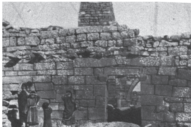
Fig. 7. Fotografia della parte settentrionale della facciata della chiesa scattata da Renato Bartoccini negli anni trenta del novecento (Bartoccini 1941: tav. XI)
