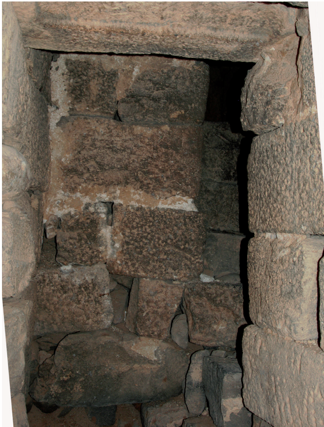
Fig. 27. Vista dall'interno della torre-minareto della tamponatura (US 1091) della porta (US 1025) per la costruzione delle scale (fotografia di Roberto Parenti)
