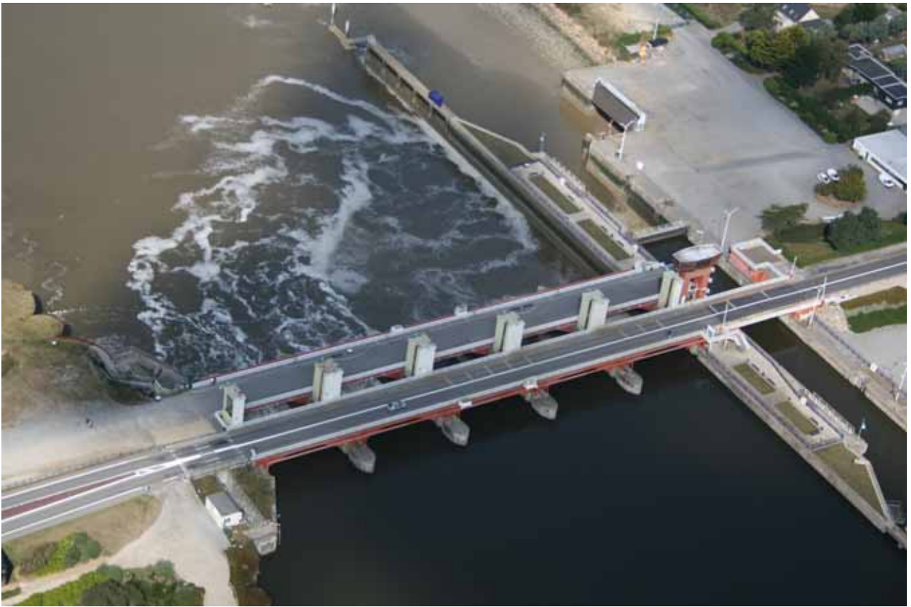
Le barrage d'Arzal
