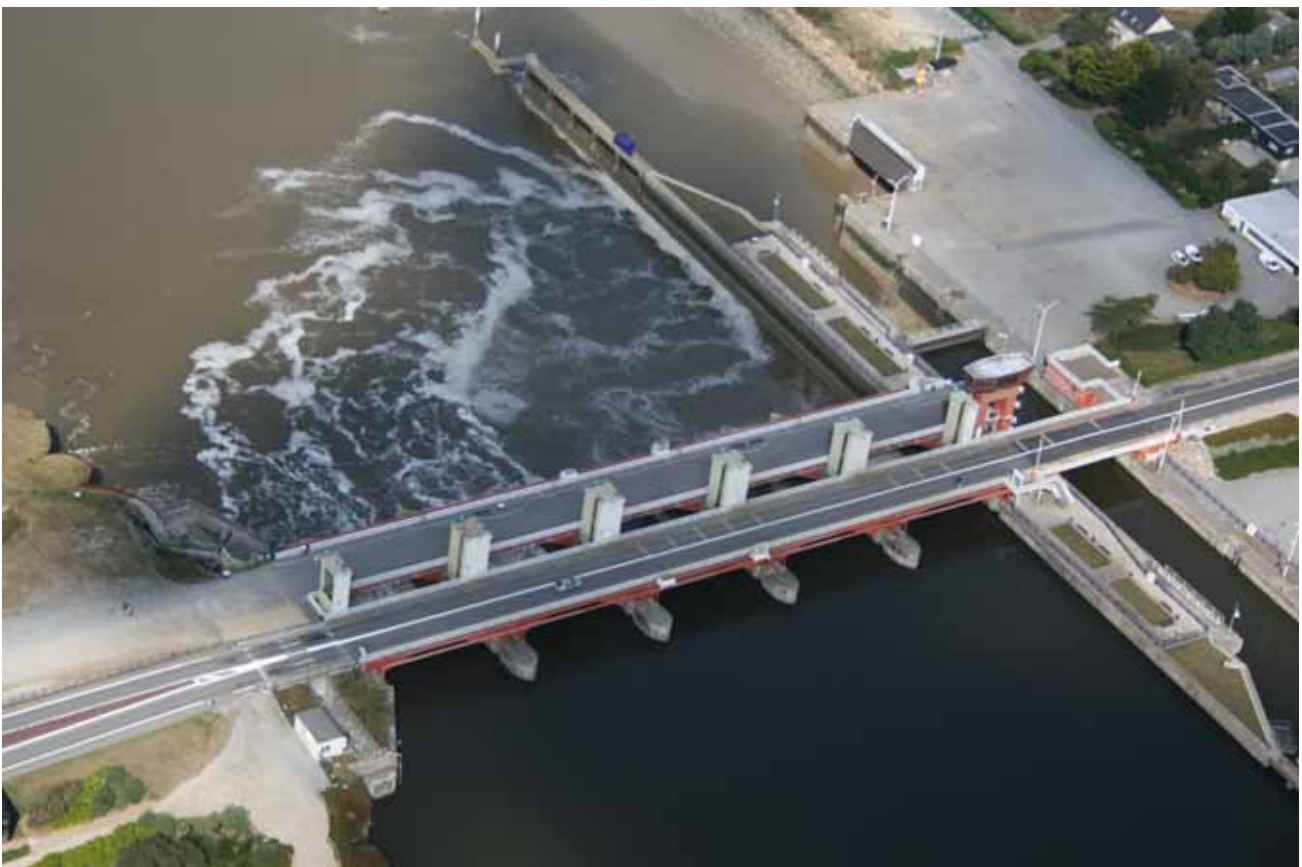
Le barrage d'Arzal
