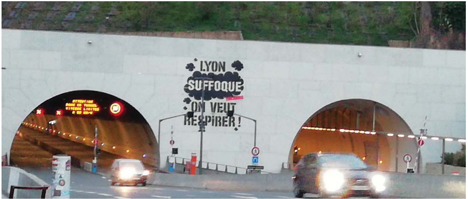
« Lyon suffoque on veut respirer » ; mars 2019, Lyon 4 ème , entrée Est du tunnel de la Croix Rouse, auteur inconnu, photo ChB
