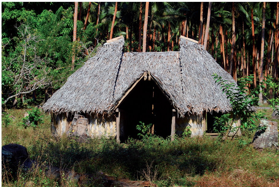
Fig. 2. Photographie de ce qui devait devenir l'université de l'État indépendant de Lamap, construite par les villageois vers 2006, puis brûlée en 2015
