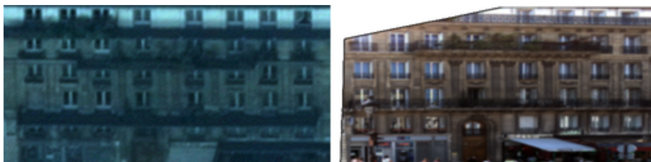
FIGURE 107 – Aucun appariement obtenu même après redressement des images et en floutant l'image la mieux résolue : l'inversion des contrastes et la texture 3D des fenêtres et des balcons perturbent l'appariement
