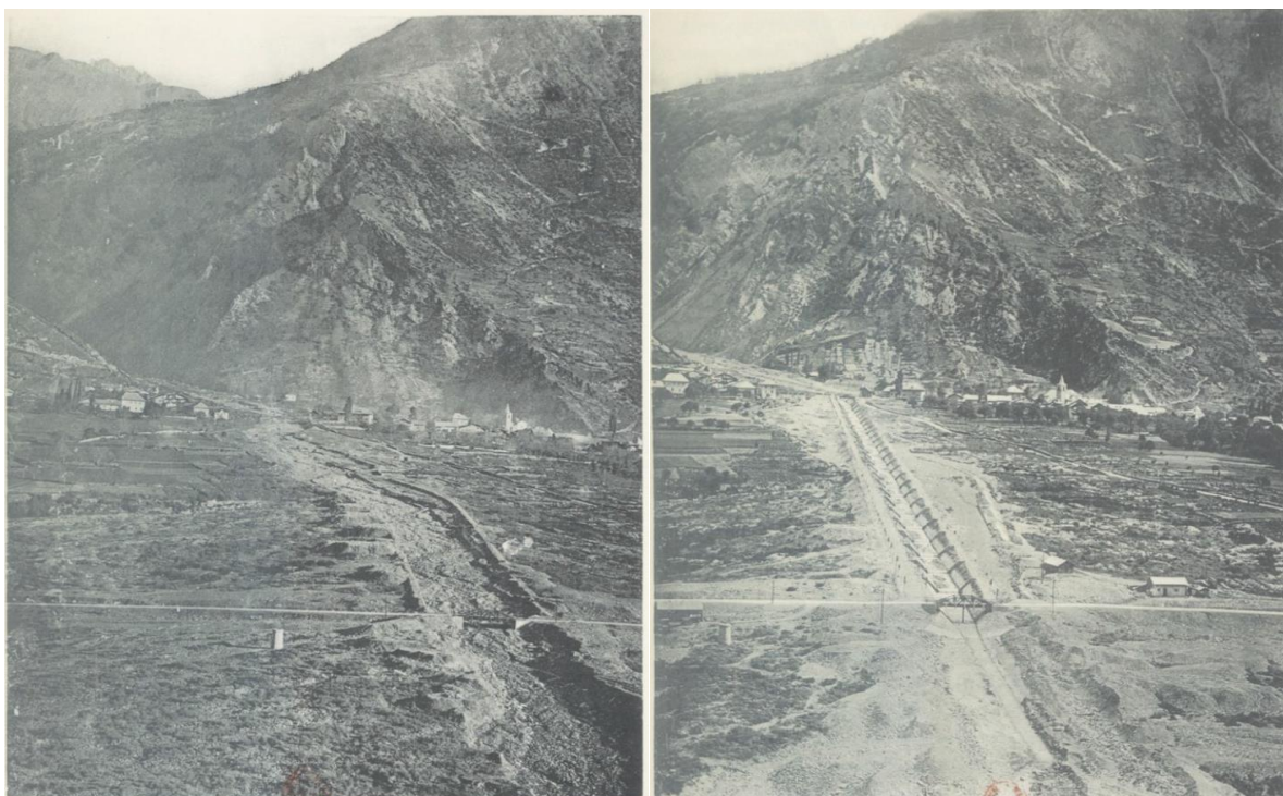
Figure 5 : Chenalisation du torrent du St Julien sur son cône de déjection (photo de gauche : 1898 ; photo de droite : 1911)(Anon 1911)
