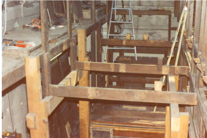
Figure 8: buffet lors du démontage, vu depuis le niveau du Récit. La photo montre la charpente ajoutée par Gutschenritter, en bois plus clair (photo Jacques Nonnet).
