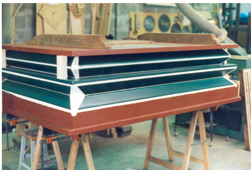
Figure 40: un des quatre réservoirs en cours de restauration (photo Jacques Nonnet).
