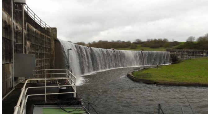
Figure 1 : Barrage de Ribou
