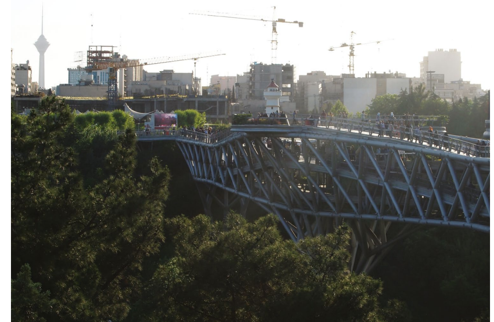
Pont piétonnier Tablath Bridge, Téhéran, Iran, 2016, Agnès et Denis Martouzet.
