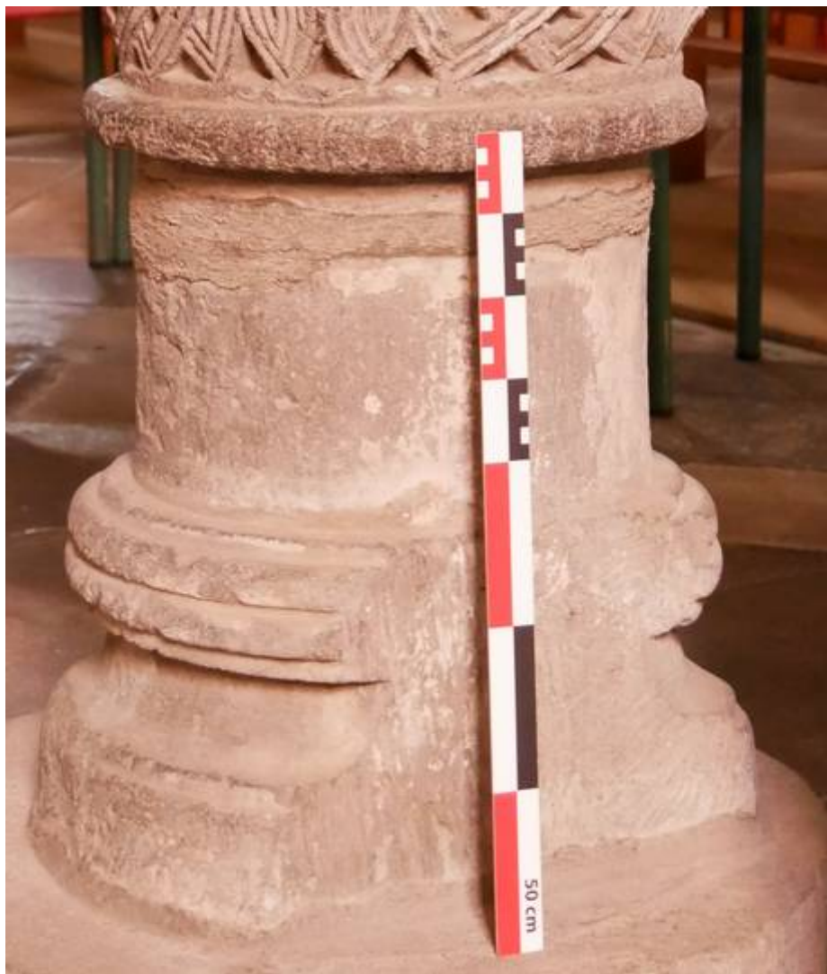
Fig. 7 : Base de tambour dans la première travée de la nef de l'abbatiale Saint-Géraud
