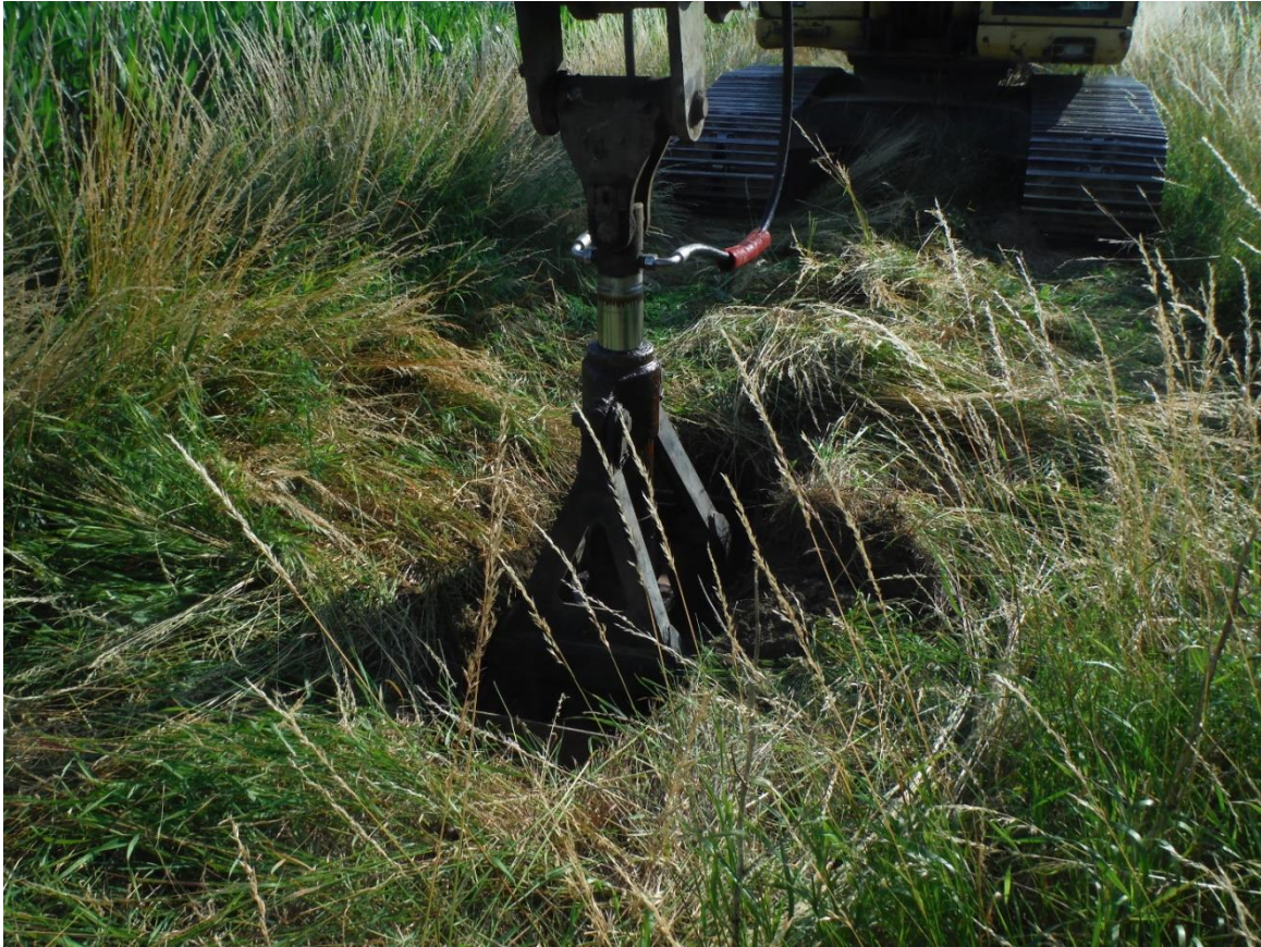
Figure 17 : SP1, exemple de creusement au godet preneur.
