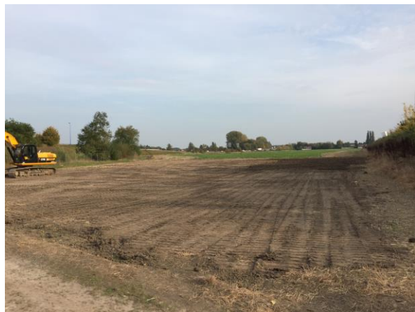
Figure 48 : Vues du rebouchage pas passes successives de la tranchée de fouille du 16 au 19 octobre 2017.
