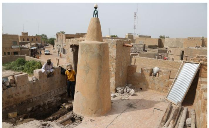
**Vue de l'ouverture réalisée en toiture pour compléter le diagnostic de son état**
