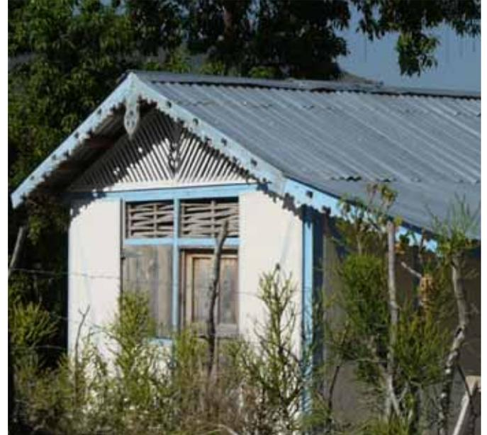
la toiture de la galerie est structurellement indépendante de la toiture principale ce qui limite les risques d'arrachement de l'ensemble en cas de vents violents.
