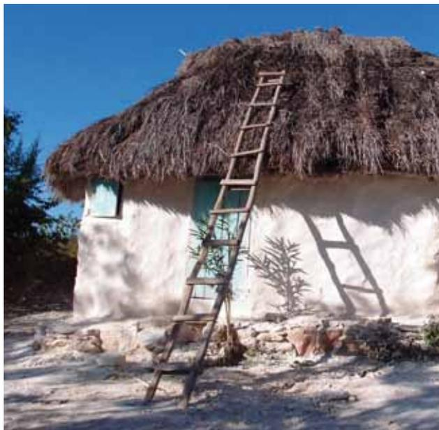
Les toitures en vetiver peuvent être entretenues à moindre coût et ne sont pas dangereuses en cas de dégradations lors d'un cyclone. Les murs de cette construction sont en clissage enduit (*klisay*).
