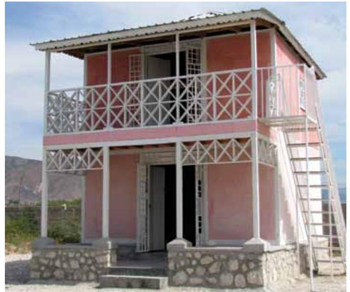
Une pépinière d'entreprises construite par EDM à Corail Croix des Bouquets en ossature bois et remplissage en débris maçonnés.
