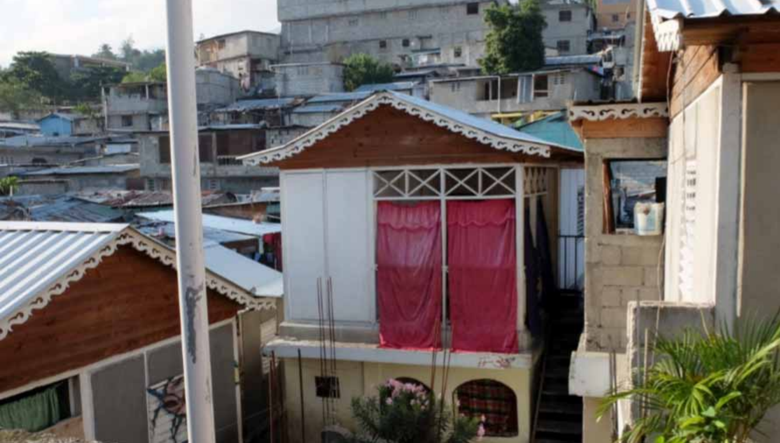
Port-au-Prince, un exemple des extensions en étage construites en ossature bois sur des RDC en maçonnerie chaînée
