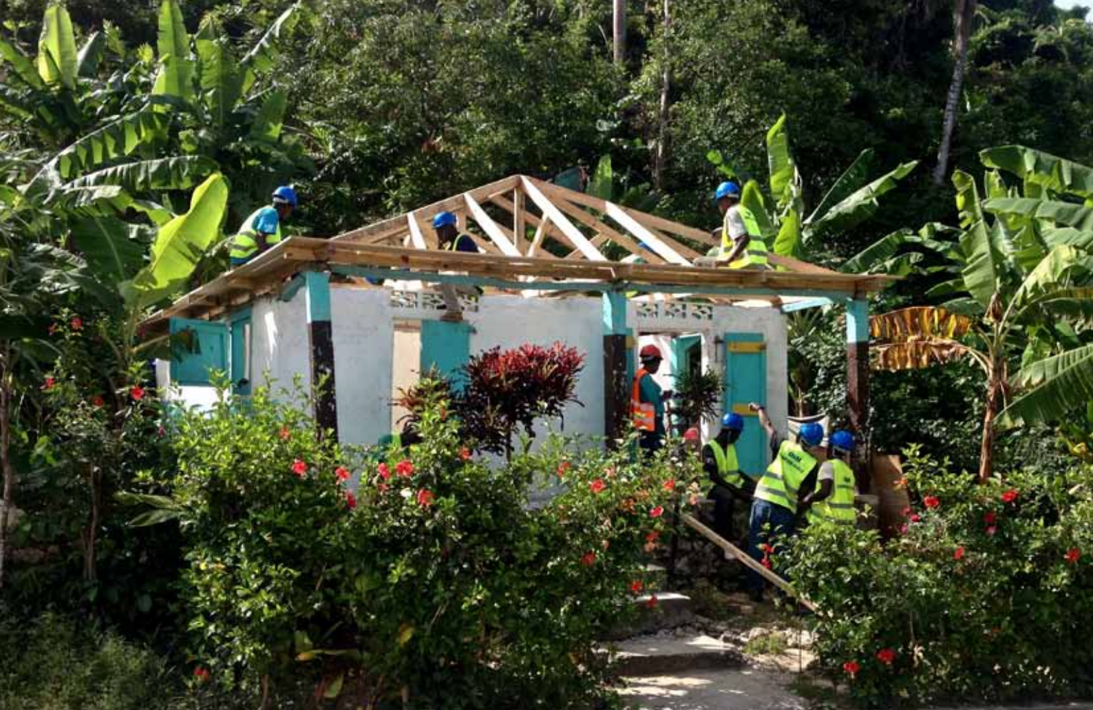
La promotion d'une démarche de réparation et de renforcement des toitures s'est traduit par la mise en place de formations spécifiques par le Groupe de Travail, ici à Abricots. © Kettie Jean
