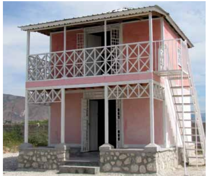
Une pépinière d'entreprises construite par EDM à Corail Croix des Bouquets en ossature bois et remplissage en débris maçonnés.
