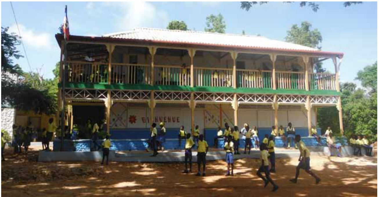
Bâtiment préscolaire de l'école de Grand Boulage, Thomaseau : L'étage est desservi par une coursive, utilisée pour les pauses et déjeuners.
