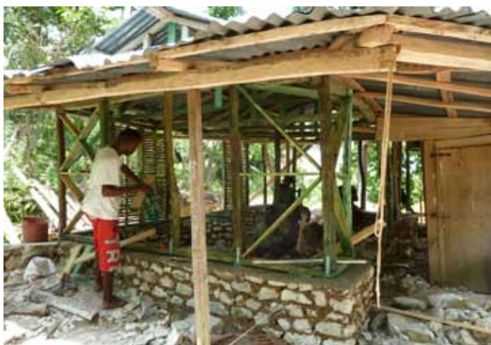
Chantier de réparation d'une maison existante dans le cadre du programme mené par EPPMPH (mai 2013). Ce chantier a été l'occasion d'améliorer certains détails constructifs, entre autres : contreventement de la structure, soubassement, ancrage de la toiture. © EPPMPH
