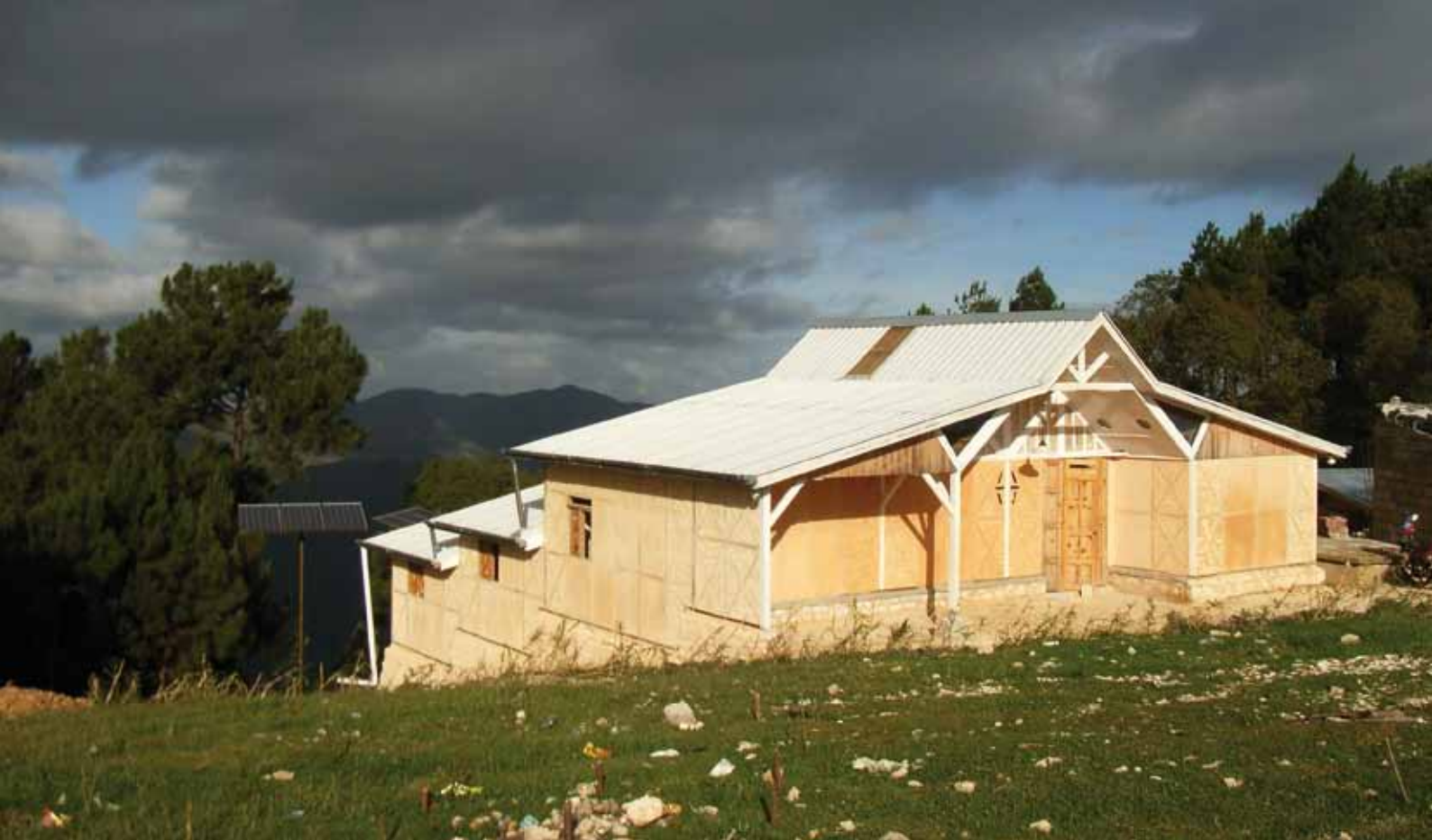
Les bureaux de GADRU à Belot, construits en TCLA.
