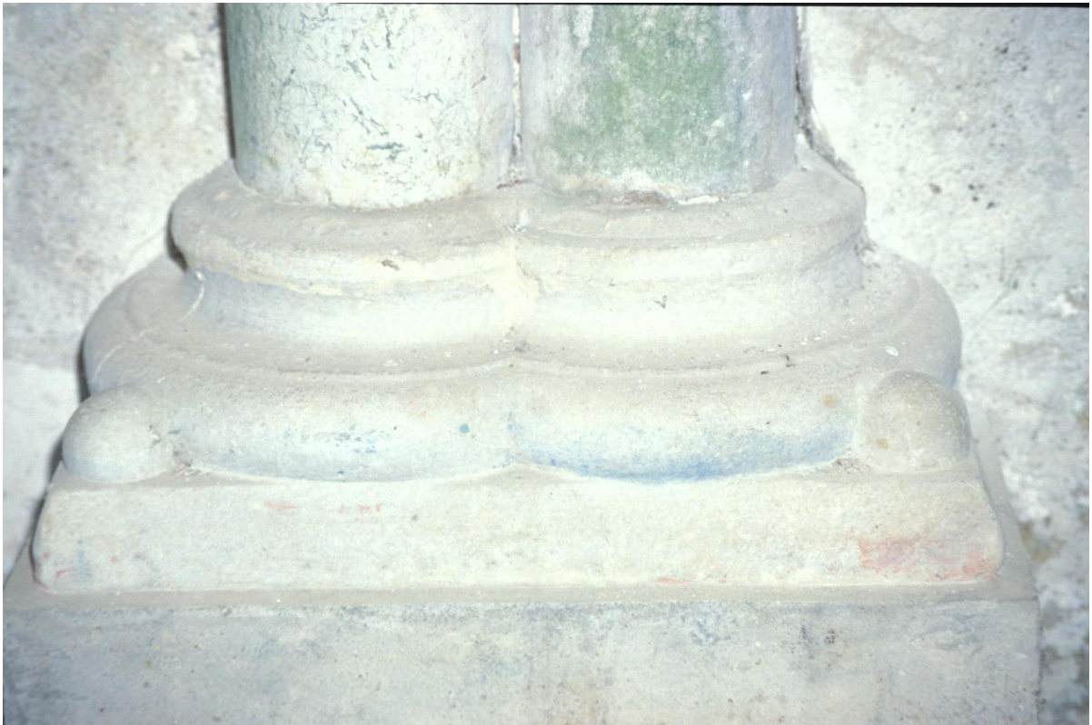
Fig. 18 : Berdoues, ancienne chapelle, la base du support 15.
