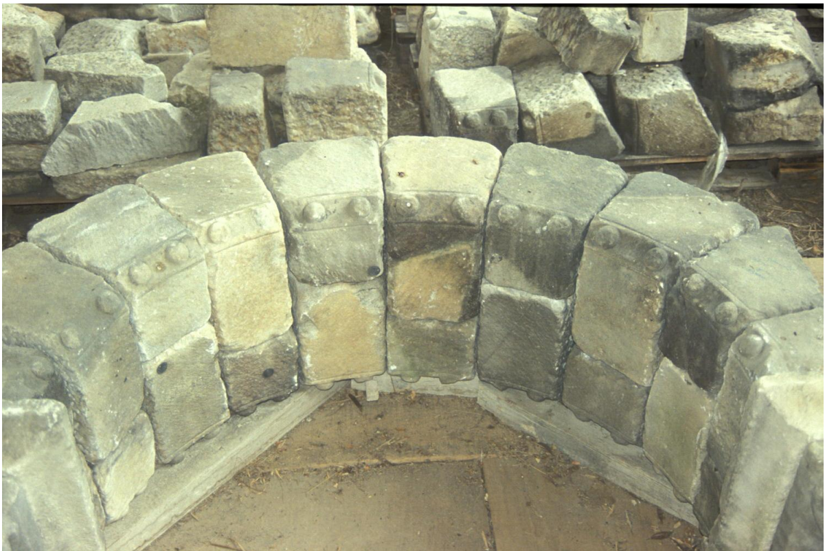
Fig. 4 : Détail de l'arcade remontée.
