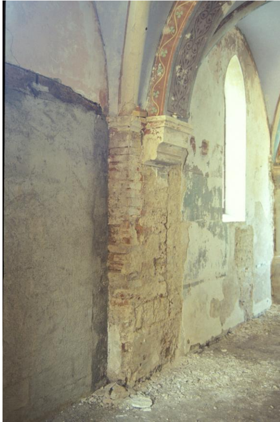
Fig. 11 : Berdoues, ancienne chapelle, détail de l'élevation intérieure.
