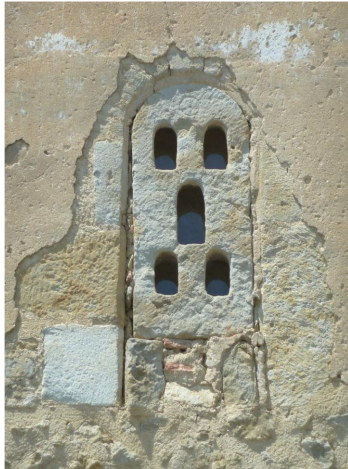
Fig. 16 : Saramon, ancienne abbatale, la tour Saint-Victor, la claustra orientale.
