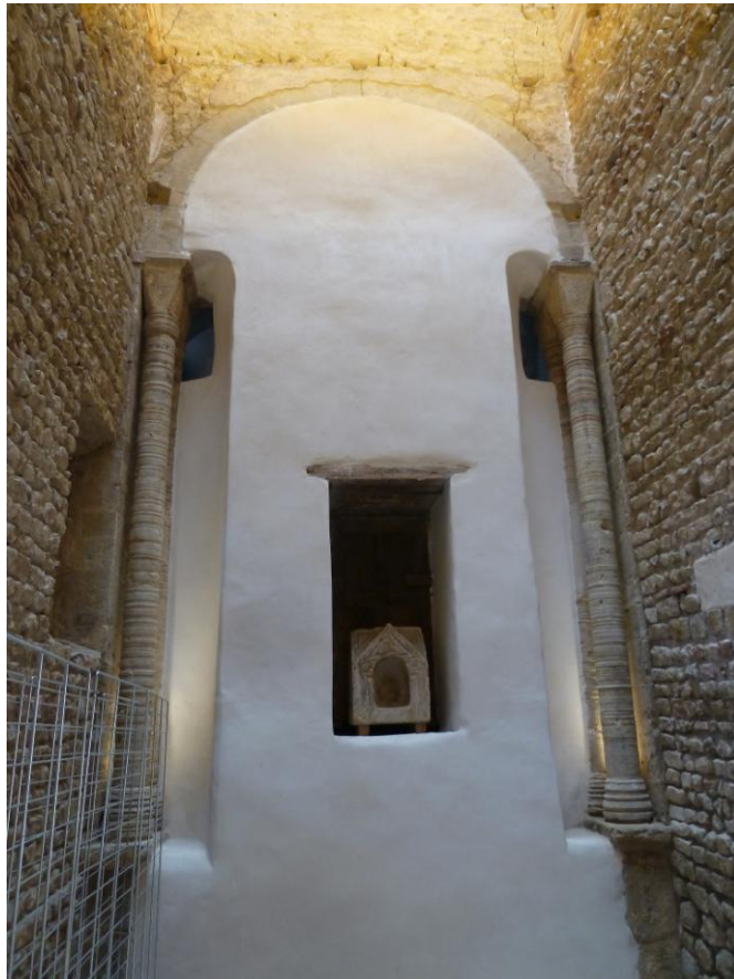
Fig. 14 : Saramon, ancienne abbatale, la tour Saint-Victor, vue intérieure vers l'ouest.
