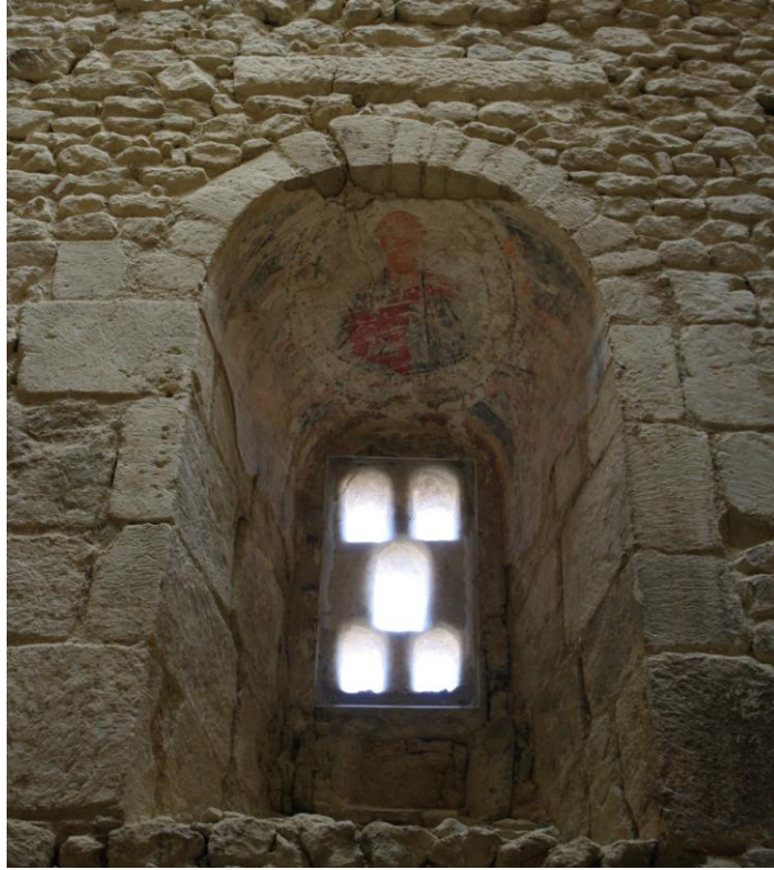
Fig. 15 : Saramon, ancienne abbatale, la tour Saint-Victor, vue intérieure vers l'est.
