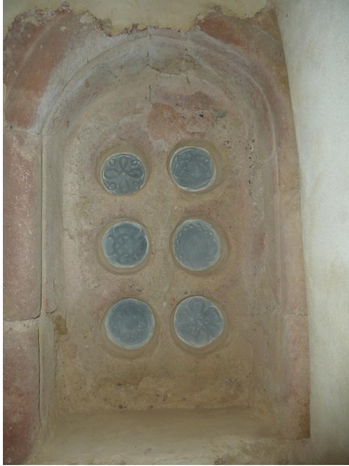
Fig. 17 : Château du Garrané, chapelle, une des deux claustras .
