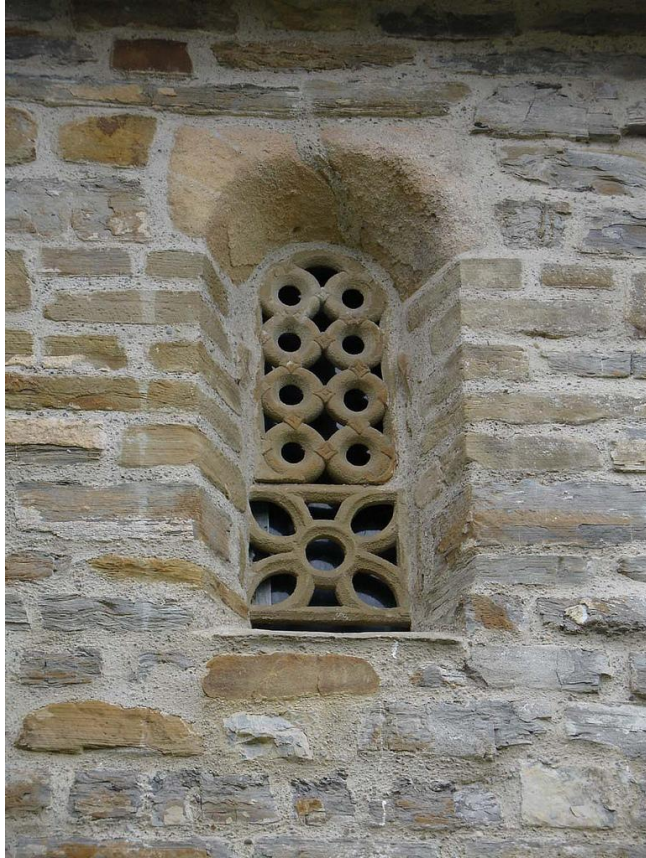
Fig. 13 : L'Hôpital-Saint-Blaise, église Saint-Blaise, détail d'une baie ajourée.
