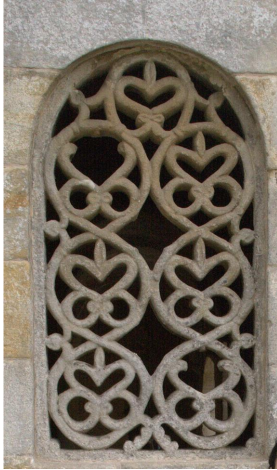
Fig. 5 : San Salvador de Valdedios, portique sud, la baie ouest.
