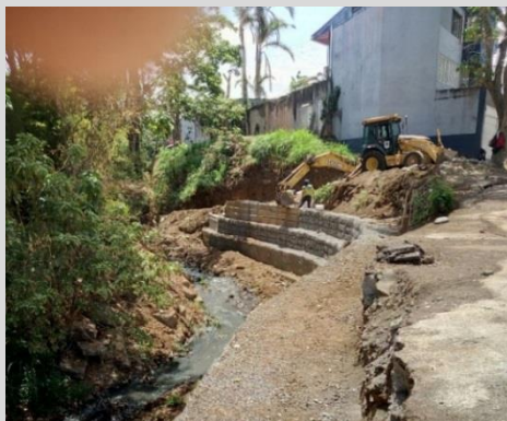
Foto 28. Obras en cauce por el Municipio de Montes de Oca, Alerta temprana Ocloro , abril 2017.
