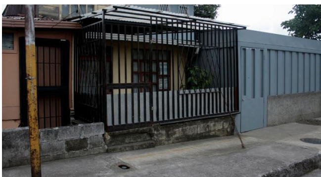
Foto 18. Barreras o paredes de hormigón y zinc para proteger los hogares. Guevara Viquez, agosto de 2016.
