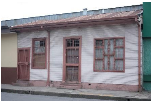
Foto 1. Arquitectura obrera en Barrio Luján. S. Guevara Viquez, julio de 2016.
