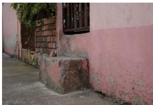
Foto 19. Elevación de casa. Guevara Viquez, agosto de 2016.
