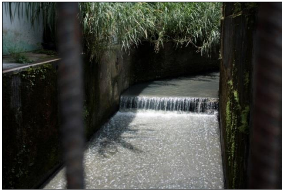
Foto 11. Punto 1 del mapa 4. Canal de cuatro metros de alto y tres metros de ancho en Barrio Luján (Punto PT_15 del informe DEHC 2018 p.83). Foto: Guevara Viquez, Agosto 2016.
