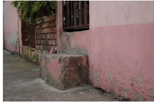
Foto 19. Elevación de casa. Guevara Viquez, agosto de 2016.
