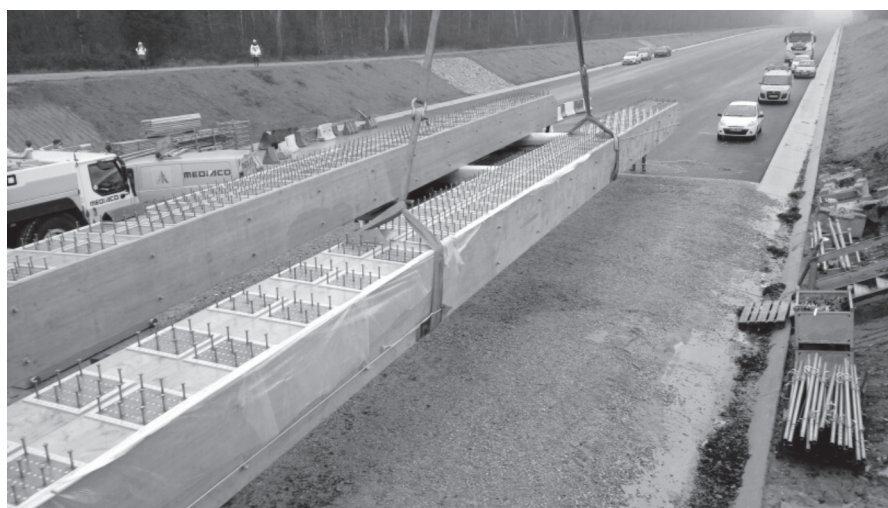
Figure 6. Poutres du pont d'Amblans et Velotte, (crédit photo : CEREMA Est)
