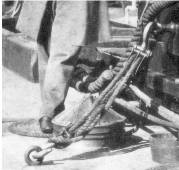
Figure 73 – Photographie prise à Capetown, montrant le palan de pointage du canon de 8 pouces.
