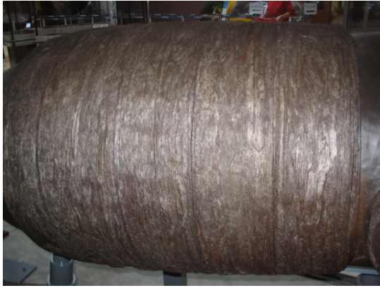
Figure 21 - Vue sur le côté droit des 5 frettes en fer forgé (photos J. Guesnon)
