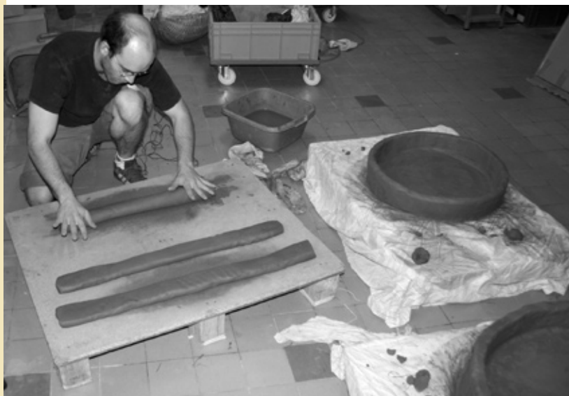
Figure 5 : Façonnage des parois du four expérimental par l'adjonction de gros boudins aplatis (cliché : M. Remicourt).
