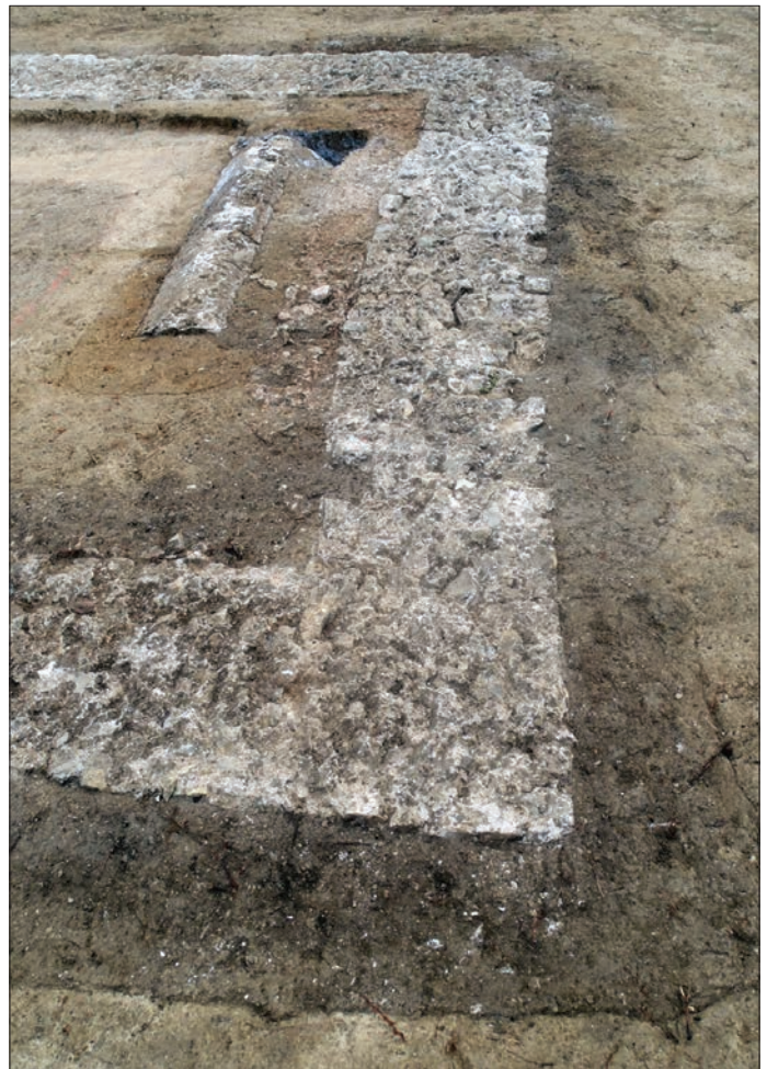
Fig. 21 – Mur méridional du mausolée vu depuis l'ouest (cliché : C. Vasnier, Archeodunum).
