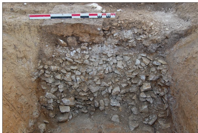
Fig. 5 – Fondations du bâtiment 2 (cliché : M. Segard).
