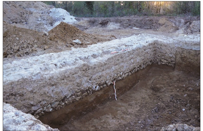
Fig. 20 – Vue des fondations du mur nord du mausolée (cliché : M. Segard).
