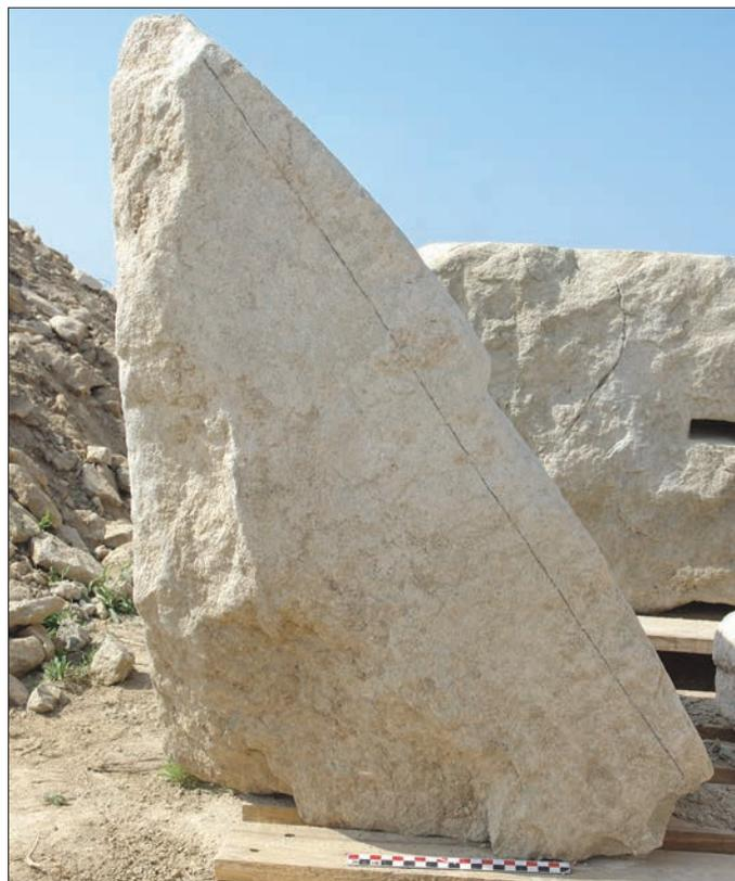
Fig. 13 – Bloc n<sup>o</sup> XI du mur sud ou nord du mausolée avec un lit d'attente convexe divisé en deux surfaces ; le tracé au crayon matérialise l'hypoténuse d'un triangle rectangle (cliché : R. Pellé).
