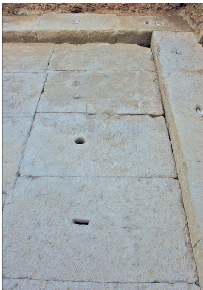
**Fig. 9** – Partie septentrionale de la chambre : le bloc central est percé d'un trou circulaire d'une douzaine de centimètres pour une profondeur d'une vingtaine de centimètres (cliché : R. Pellé).
