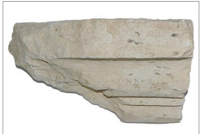
Fig. 7 – Fragment d'un bloc (n° XXVII) de corniche en calcaire lacustre : la modénature est apparemment identique à celle des blocs de grès (cliché : R. Pellé).
