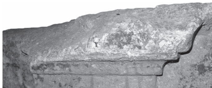
Fig. 11 – Fût de pilastre lisse et chapiteau toscan du bloc 5-4 (cliché : S. Février).
