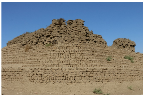
Fig. 36. Bâtiment sur plate-forme au nord de la première cour : vue générale de la restauration
