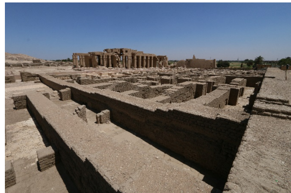
Fig. 41 et 42. Vues générales montrant le principe de restauration adopté pour les murs du Ramesseum : plusieurs couches de briques neuves au-dessus des structures anciennes.
