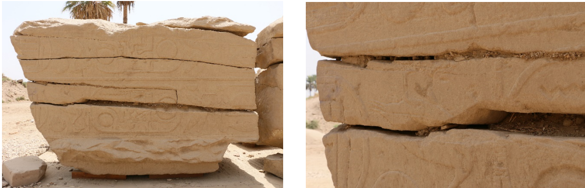
Fig. 10 et 11. Un des blocs de pierre stockés dans la zone au nord de la salle hypostyle du temple de Karnak montre bien la force que les racines de halfa sont capables d'exercer, ici en soulevant la partie supérieure du bloc.
