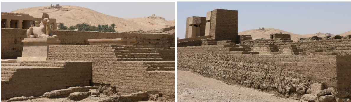
Fig. 48 et 49. Deux vues de la façade est des restaurations faites sur les maçonneries du temple mémorial d'Amenhotep II.
