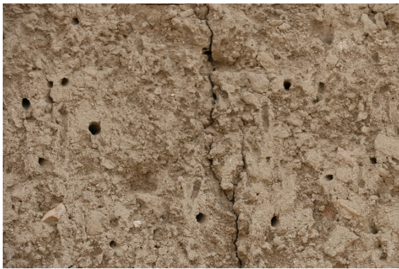
Fig. 25. Orifices creusés par des insectes.
