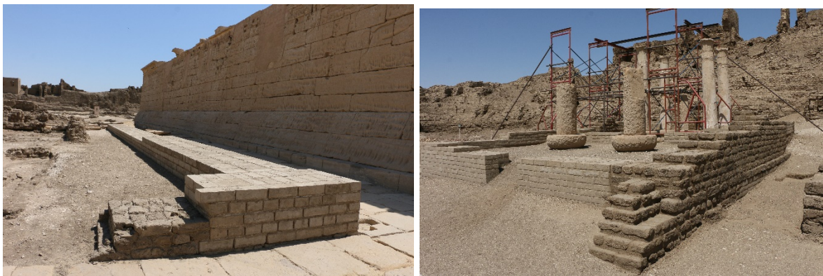
Fig. 44 et 45. Temple de Medinet Habou : les briques de terre utilisées sont de grande taille et d'aspect très « lisse », ce qui jure un peu avec l'original.
