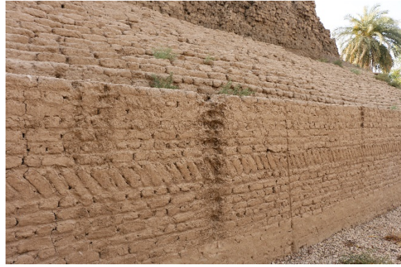
Fig. 40. Concentration d'eaux avec érosion.
