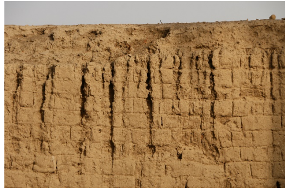
Fig. 15. Écoulements entraînant des ravinements.
