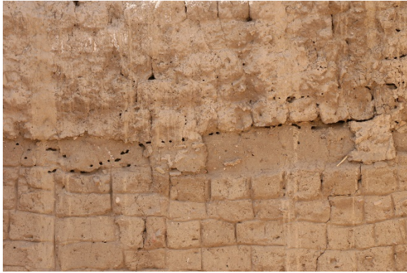
Fig. 14. Traces d'écoulement et de ré-déposition.
