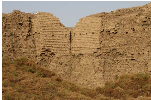
Fig. 17. Angle nord-est de l'enceinte (intérieur)
