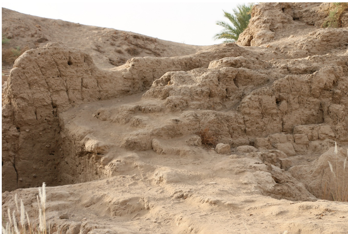
Fig. 24. Dégradation typique liée au passage de « visiteurs » sur un mur en briques de terre.
